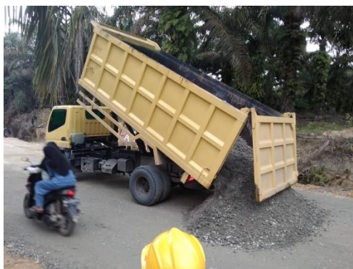
Gambar 3.11 penghamparan base A ( Sumber: Dokumentasi Kerja pratek, 2023 )
