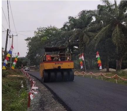
Gambar 3.18 pekerjaan pemadatan akhir ( Sumber: Dokumentasi KP, 2023 )
