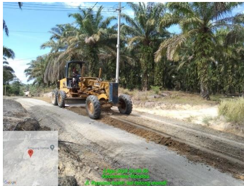
Gambar 4.6 : penghamparan base A menggunakan motor grader
