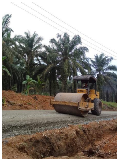
Gambar 4.10 : proses finishing base A ( Sumber : Dokumentasi KP, 2023)
