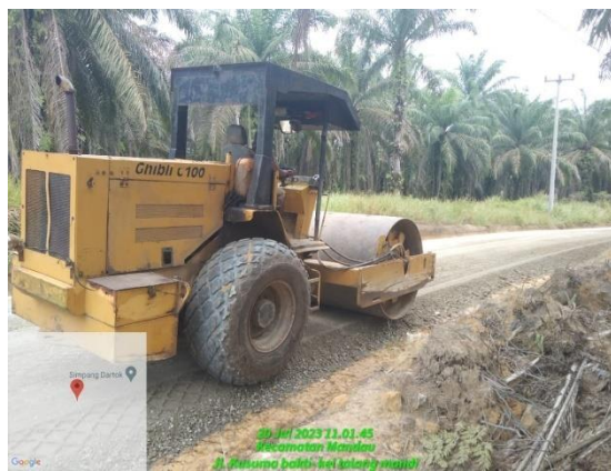
Gambar 4.7 : Pemadatan pondasi agregat kelas A menggunakan Vibratory roller ( Sumber : Dokumentasi KP, 2023)
