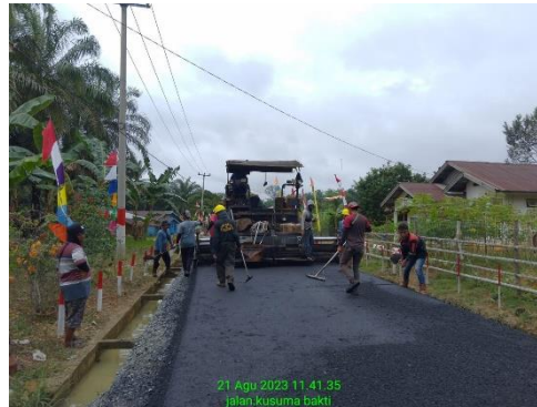
Gambar 3.16 pekerjaan pengaspalan ( Sumber: Dokumentasi KP, 2023 )
