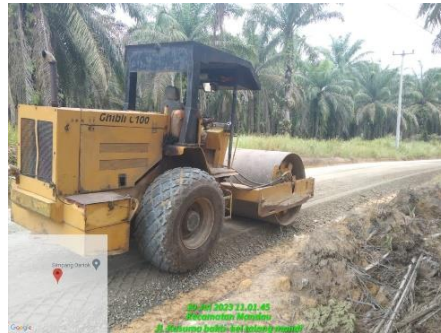
Gambar 4.2 : Vibratory roller ( Sumber : Dokumentasi KP, 2023)
