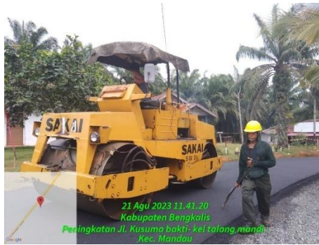
Gambar 3.17 pekerjaan pemadatan awal ( Sumber: Dokumentasi KP, 2023 )
