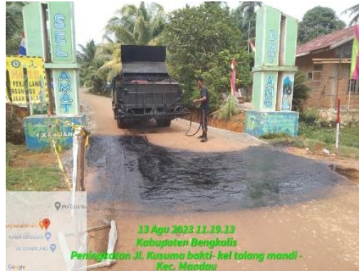
Gambar 3.15 pekerjaan Primecoat ( Sumber: Dokumentasi KP, 2023 )
