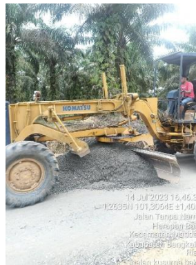
Gambar 4.3 : Motor Grader ( Sumber : Dokumentasi KP, 2023)
