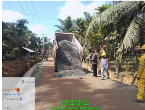
Gambar 4.5 : penghamparan base A dari dump truck ( Sumber : Dokumentasi KP, 2023)
