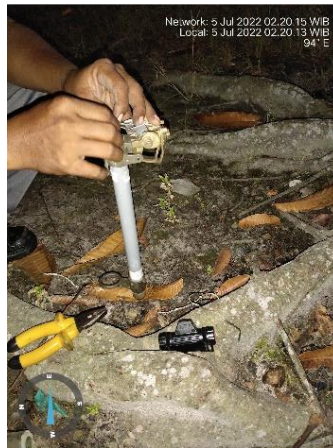
Gambar 2.12 Memperbaiki FCO (Sumber: Dokumentasi)
