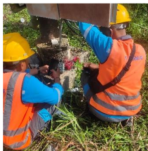
Gambar 2.3 Pengecekan ukuran grounding PHB TR (Sumber: Dokumentasi)
