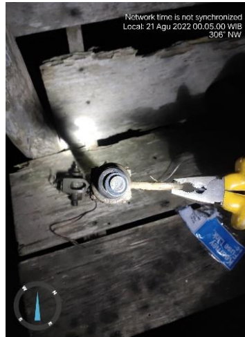
Gambar 2.39 Penggantian Fuse link (Sumber: Dokumentasi)
