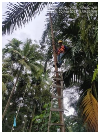
Gambar 2.38 Memperbaiki Kabel SKU (Sumber: Dokumentasi)
