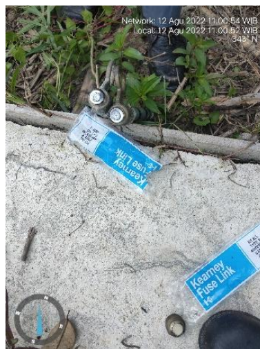
Gambar 2.31 Penggantian Fuse Link (Sumber: Dokumentasi)
