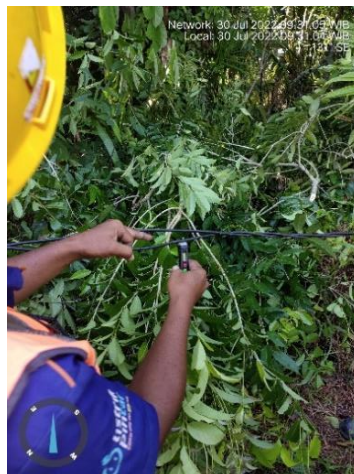
Gambar 2.25 Perbaikan Kabel SKU (Sumber: Dokumentasi)
