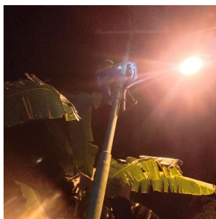
Gambar 2.35 Memperbaiki Pering Pelanggan (Sumber: Dokumentasi)
