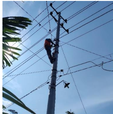
Gambar 2.34 Memperbaiki Pering Pelanggan (Sumber: Dokumentasi)
