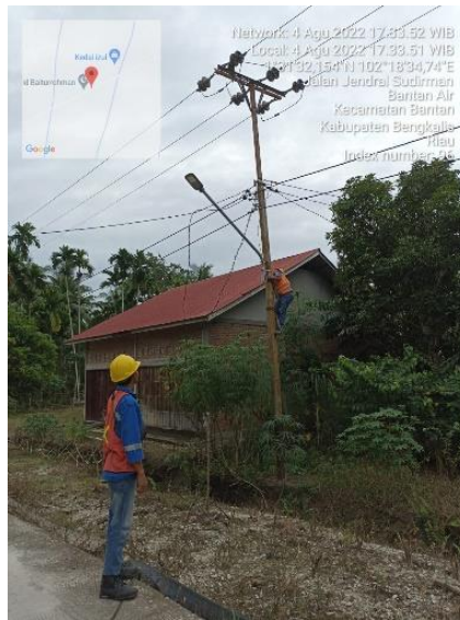
Gambar 2.28 Perbaikan Kabel SR (Sumber: Dokumentasi)
