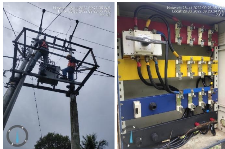
Gambar 2.24 Pemeliharaan PHB TR (Sumber: Dokumentasi)
