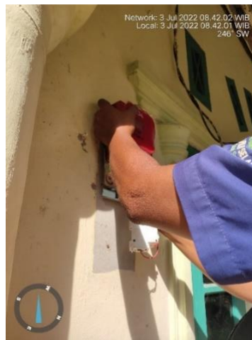
Gambar 2.10 Pemasangan kWh Meter Sementara (Sumber: Dokumentasi)
