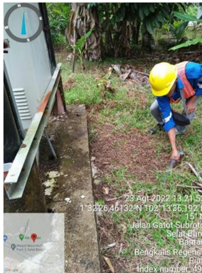
Gambar 2.41 Pembersihan Area Gardu (Sumber: Dokumentasi)
