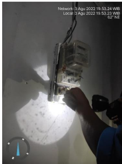
Gambar 2.26 Penggantian MCB (Sumber: Dokumentasi)
