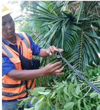
Gambar 2.34. Perbaikan kabel SR putus (Sumber: PT. Adra Gemilang)
