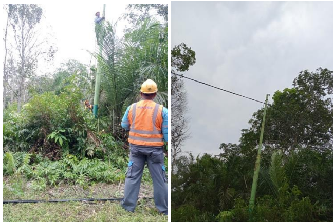
Gambar 2.41. Perbaikan kabel SKU jatuh (Sumber: PT. Adra Gemilang)
