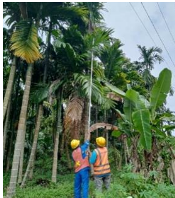
Gambar 2.20. Pembersihan dahan pohon (Sumber: PT. Adra Gemilang)
