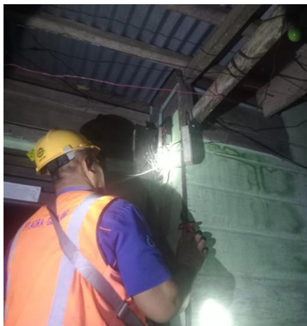
Gambar 2.57. Perbaikan instalasi Kwh meter (Sumber: PT. Adra Gemilang )
