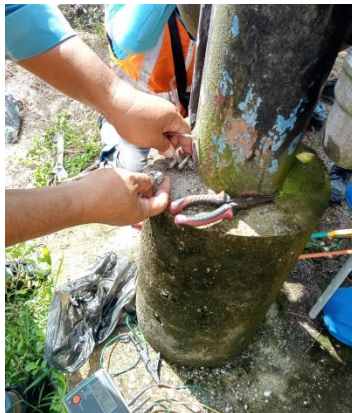
Gambar 2.32. Perbaikan grounding trafo distribusi (Sumber: PT. Adra Gemilang)
