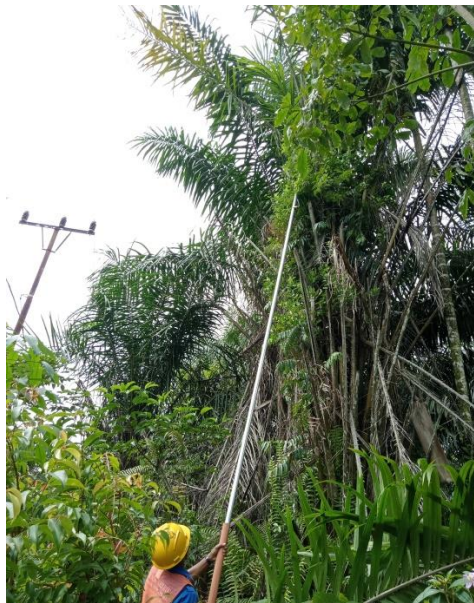
Gambar 2.23 Pembersihan dahan pohon (Sumber: PT. Adra Gemilang).
