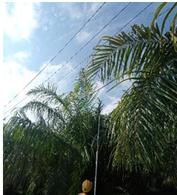
Gambar 2.17. Pembersihan dahan pohon (Sumber: PT Adra Gemilang)
