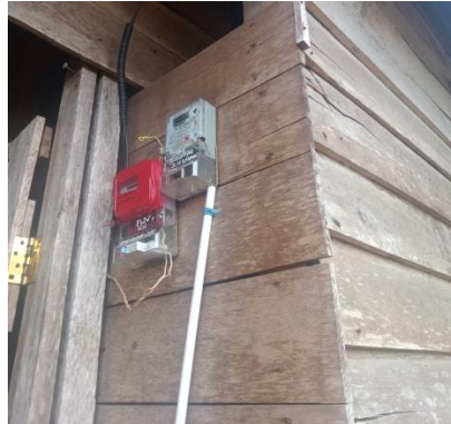
Gambar 2.35. Penggantian Kwh dummy sementara (Sumber: PT. Adra Gemilang)
