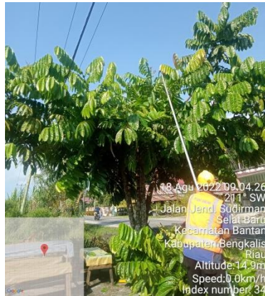
Gambar 2.50. Pembersihan dahan pohon (Sumber: PT. Adra Gemilang)
