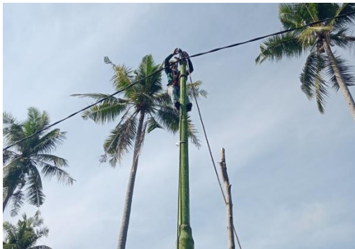
Gambar 2.29. Memperbaiki kabel SKU jatuh (Sumber: PT. Adra Gemilang)
