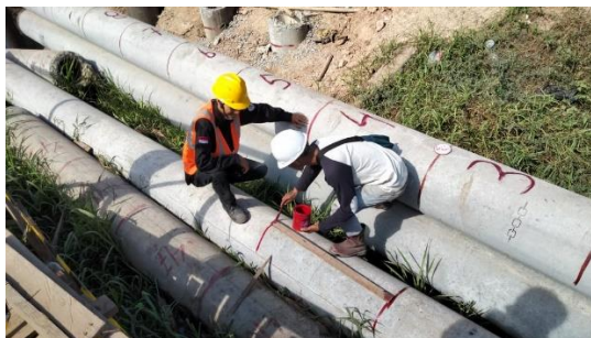
Gambar 4. 6 Proses Pemberian Tanda Ukuran Tiang Pancang
