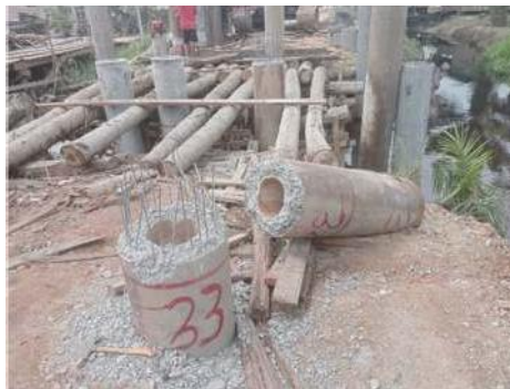
Gambar 3. 4 Pemotongan Tiang Pancang
