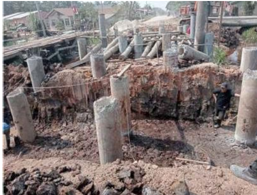
Gambar 3. 7 Pondasi yang selesai Digali
