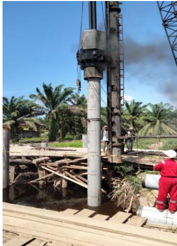
Gambar 4. 7 Proses Pemancangan Lanjutan
