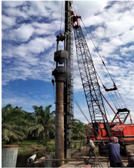
Gambar 4. 5 Proses Pemukulan Tiang Pancang
