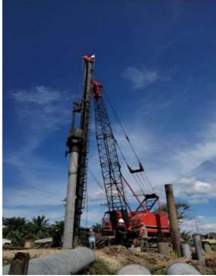
Gambar 3. 1 Pemasangan Tiang Pancang
