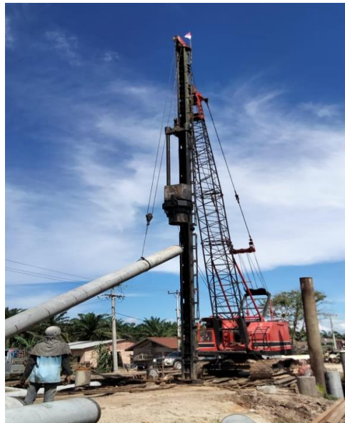
Gambar 4. 3 Proses Pengangkatan Tiang Pancang Ke Diesel Hammer
