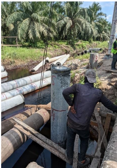
Gambar 4. 8 Pengecekan Tiang Pancang
