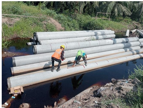
Gambar 4. 24 Tiang Pancang Bagian Sambunngan
