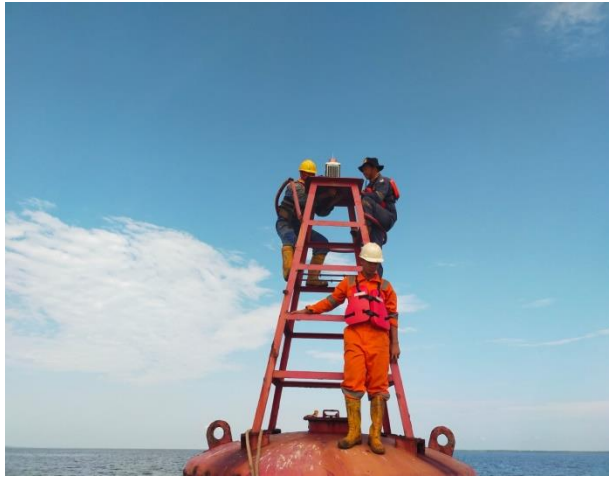
Gambar 3.1.2 Penggantian Lampu Starboard Lateral No:16
