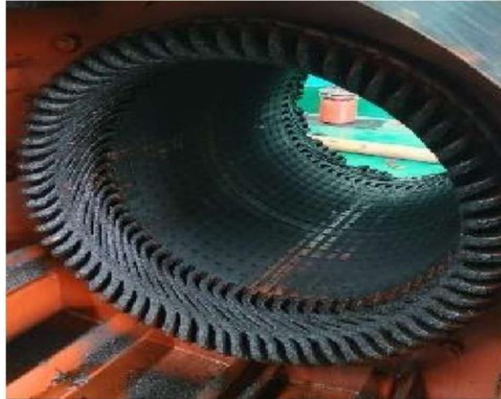
Gambar 4. 3 Kondisi Penggulungan pada Stator (2) (Sumber: Laporan Report Incoming Inspection PT. IndoTurbine)
