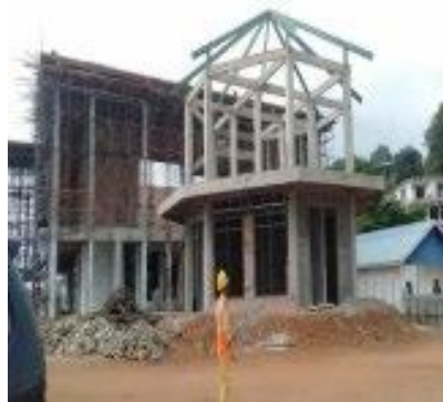
Gambar 3. 5 Pekerjaan Struktur Sumber : Dokumentasi Pribadi, 2023
