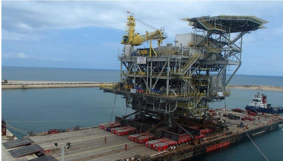
**Gambar 1.1** Proses *loadout topside* dengan metode *self propelled modular trailer* (SPMT)
