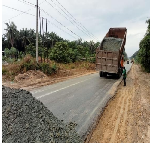
Gambar 3.16 Penuangan Material Agregat Kelas A
