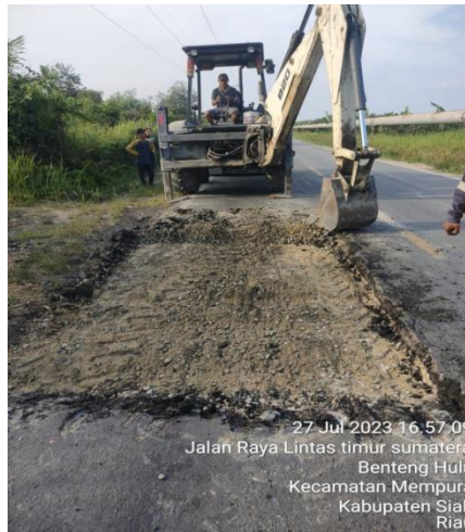
Gambar 3.20 Pembongkaran Permukaan Aspal
