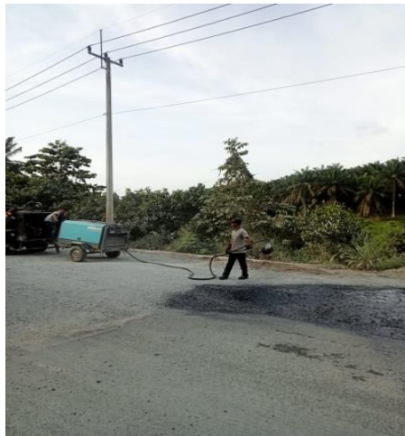
Gambar 3.26 Penyemprotan Prime Coat Sumber : Dokumentasi Kerja Praktek 2023
