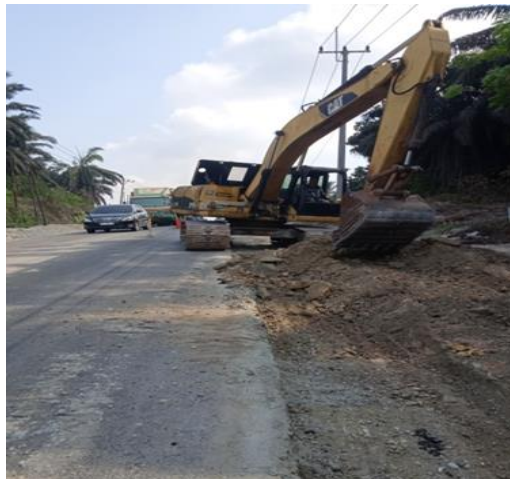
Gambar 3.13 Penggalian tanah pelebaran jalan
