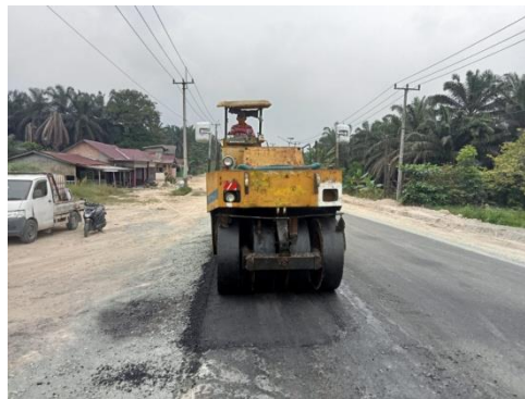
Gambar 3.29 Pemasangan CAP
