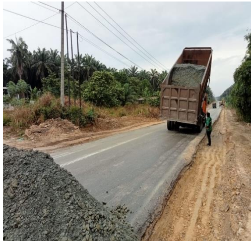
Gambar 4.11 Penuangan Base A Ke Lokasi
