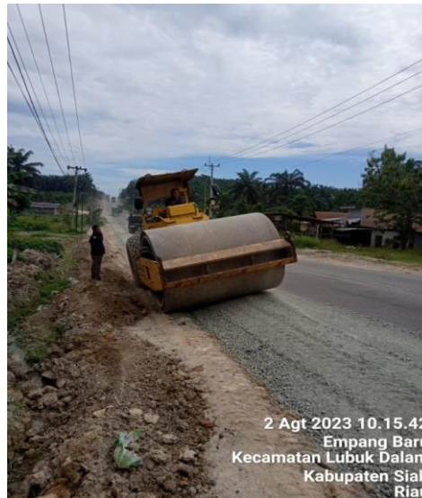
Gambar 3.18 Pematatan Timbunan Agregat Kelas A
