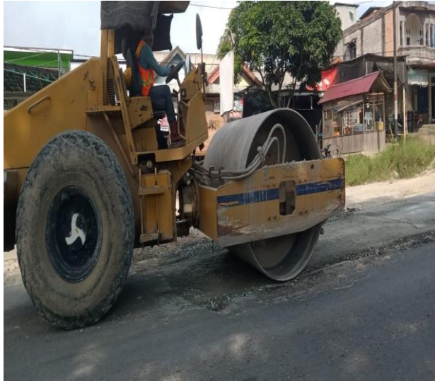
Gambar 3.24 Pemasangan Base A Pada Patching
