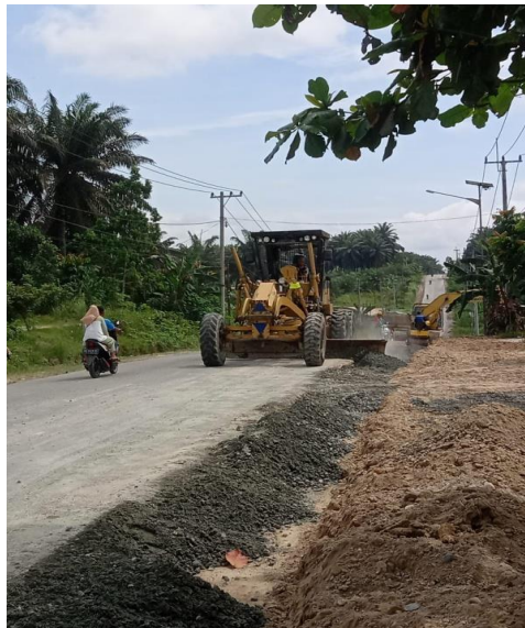
Gambar 3.17 Penghamparan Material Agregat Kelas A
