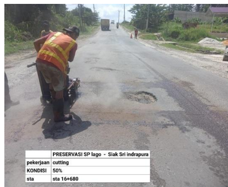
Gambar 3.19 Pekerjaan Cutting Aspal
