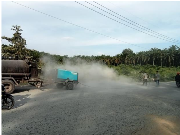
Gambar 3.25 Pembersihan Permukaan Base A Sumber : Dokumentasi Kerja Praktek 2023
