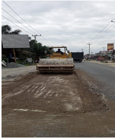
Gambar 3.22 Pekerjaan Pematatan Galian Patching
