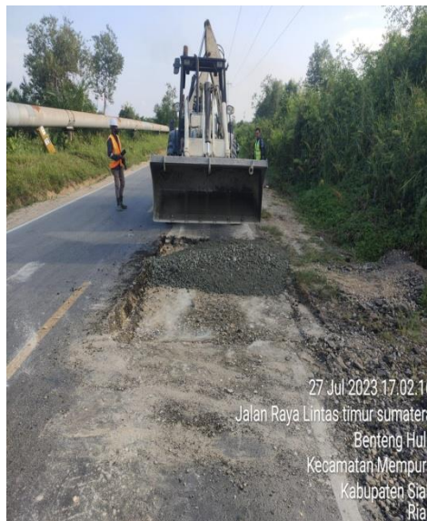
Gambar 3.23 Penghamparan Base A Pada Patching
