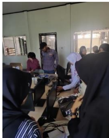
Gambar 3.5 Pemasangan Perangkat Komputer
