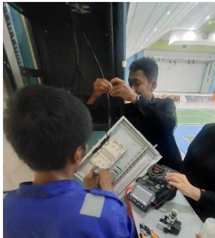
Gambar 3.8 Terminasi Fiber Optik
