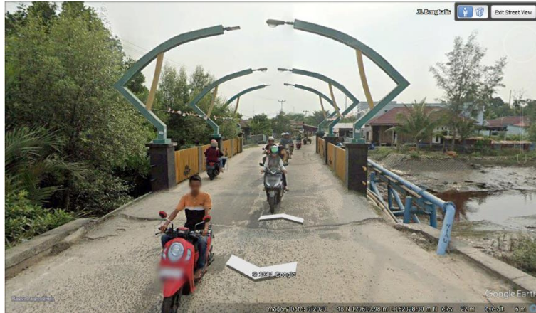
Gambar 1.2 Jembatan Bengkalis Sumber: Google Earth, 2024
