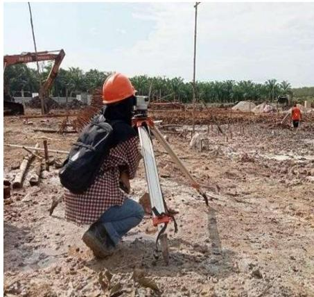
Gambar 3. 4 Pengukuran titik AS
