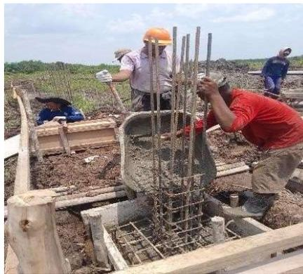
Gambar 3. 20 Pengecoran pile cap
