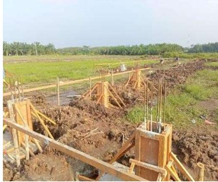
Gambar 3. 22 Pemasangan bekisting kolom pedestal
