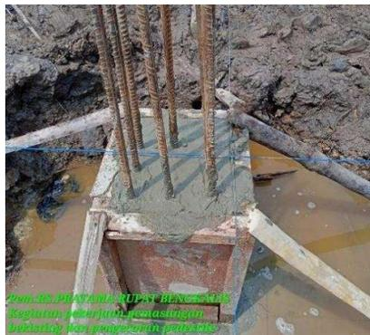
Gambar 3. 23 Pengecoran kolom pedestal
