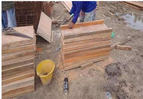
Gambar 3. 18 Pembuatan bekisting
