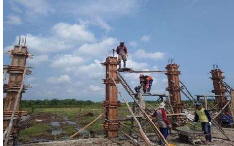
Gambar 3. 42 Proses pengecoran kolom
