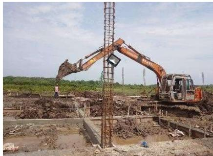
Gambar 3. 32 Proses pengurukan tanah
