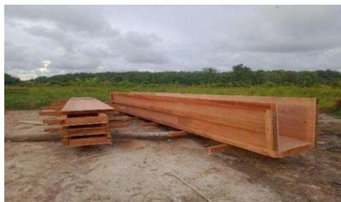
Gambar 3. 41 Pemasangan bekisting
