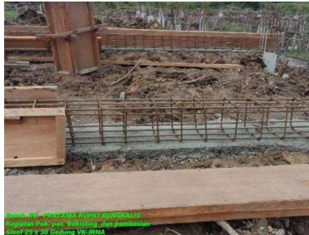
Gambar 3. 29 Proses pemasangan bekisting sloof
