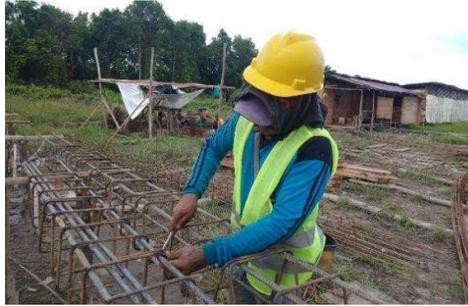
Gambar 3. 38 Proses penulangan kolom
