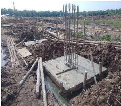
Gambar 3. 21 Hasil pengecoran pile cap
