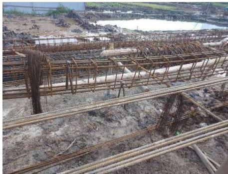
Gambar 3. 16 Penulangan kolom pedestal
