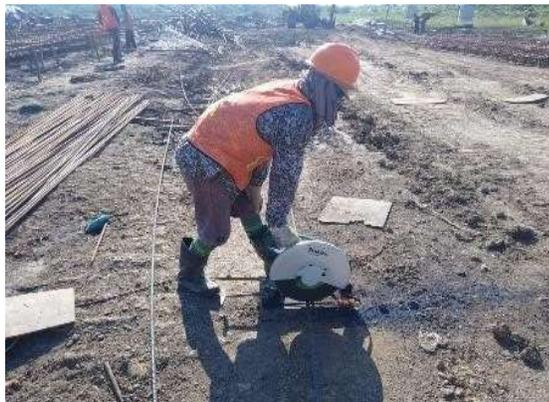
Gambar 3. 6 Pemotongan besi tulangan utama
