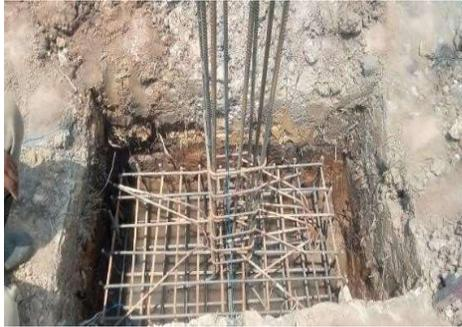
Gambar 3. 17 Pemasangan tulangan pile cap dan kolom pedestal
