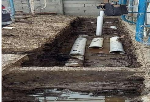
Gambar 3. 59 Pemasangan Pipa Air Kotor & Air Bersih
