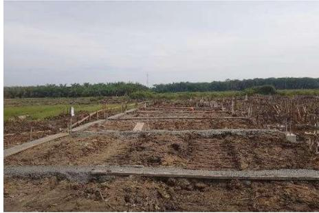
Gambar 3. 26 Penyemenan lantai tanah sloof
