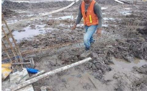
Gambar 3. 28 Proses pemasangan sloof
