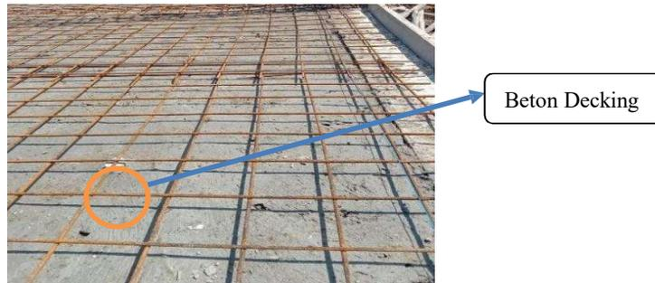
Gambar 3. 36 Proses pemasangan wiremesh dan tahu beton
