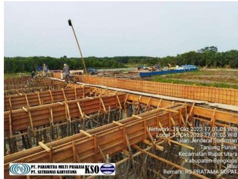
Gambar 3. 46 Pemasangan bekisting dan pengecoran balok
