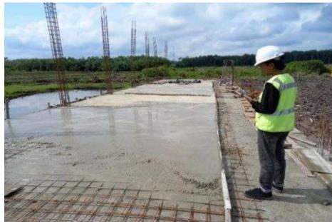
Gambar 3. 37 Proses pengecoran lantai
