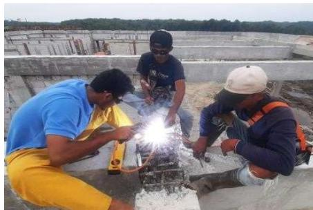
Gambar 3. 52 Proses pemasangan besi ankur
