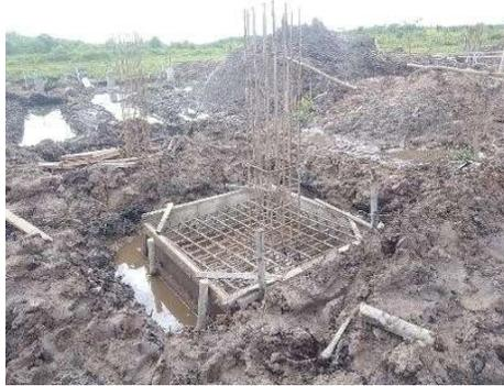
Gambar 3. 19 Pemasangan bekisting pile cap
