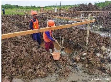
Gambar 3. 14 Pekerjaan pembobokan kepala beton
