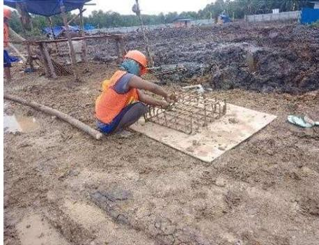
Gambar 3. 15 Penulangan pile cap
