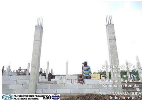
Gambar 3. 43 Pemasangan dinding bata ringan
