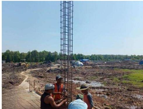
Gambar 3. 39 Proses pemasangan kolom
