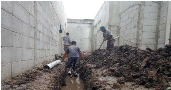
Gambar 3. 58 Pembobokan Untuk Jalur Pipa Air Kotor
