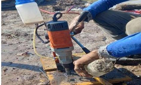
Gambar 3. 53 Pengeboran lubang sambungan baut
