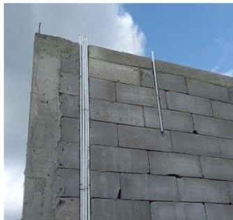
Gambar 3. 61 Pemasangan pipa listrik
