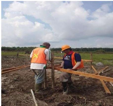
Gambar 3. 5 Pemasangan Bouwplank
