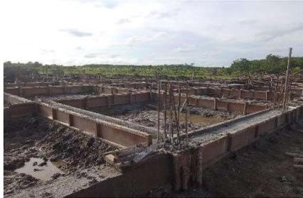
Gambar 3. 31 Proses pengecoran sloof
