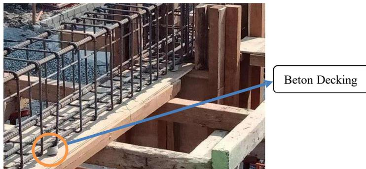
Gambar 3. 45 Pemasangan beton decking
