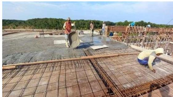
Gambar 3. 49 Pengecoran pelat lantai
