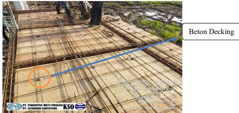
Gambar 3. 48 Pemasangan tulangan dan beton decking
