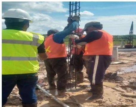
Gambar 3. 10 Proses memasukkan tulangan strauss pile
