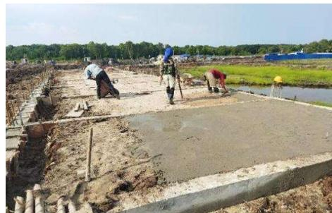
Gambar 3. 35 Proses pengecoran lantai kerja
