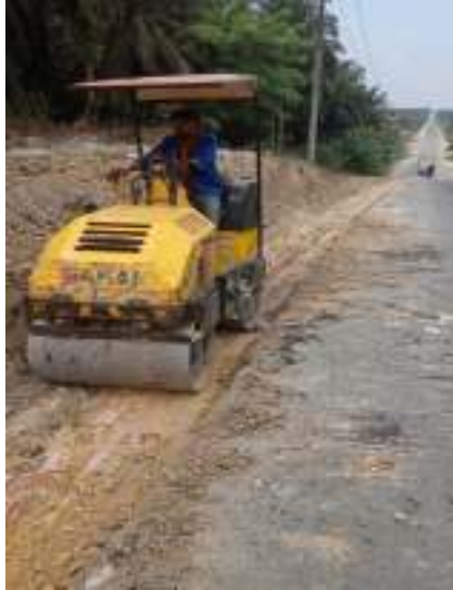
Gambar 3.14 pepadatan galian tanah pelebaran jalan
