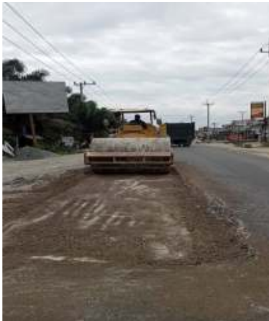
Gambar 3.21 pemasangan galian patching
