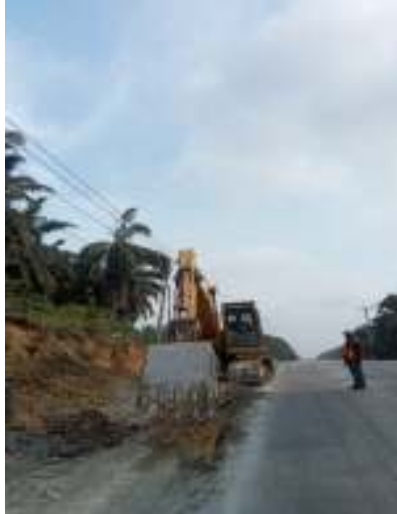
Gambar 4.6 Excavator untuk menggali tanah
