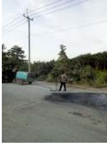
Gambar 3.26 Perkerjaan penyemprotan lapir perekat aspal ( prime coat )
