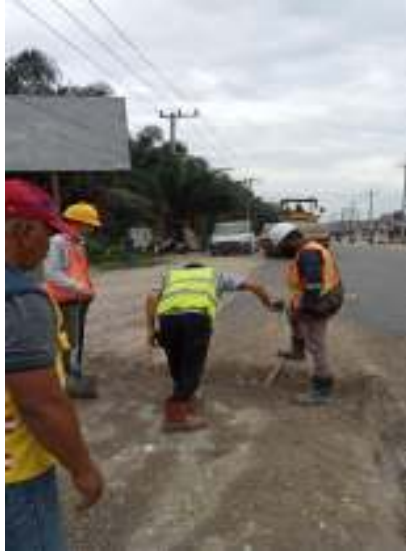
Gambar 3.20 pengukuran pembongkaran permukaan yang rusak
