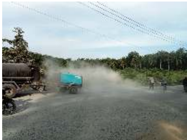
Gambar 3.25 Perkerjaan penyemprotan lapis perekat aspal (prime coat)
