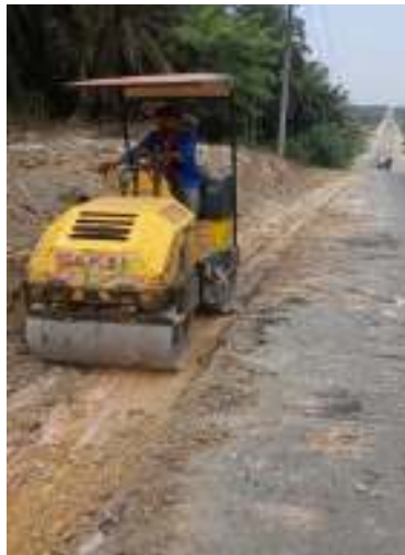
Gambar 4.7 baby roller untuk pemadatan tanah
