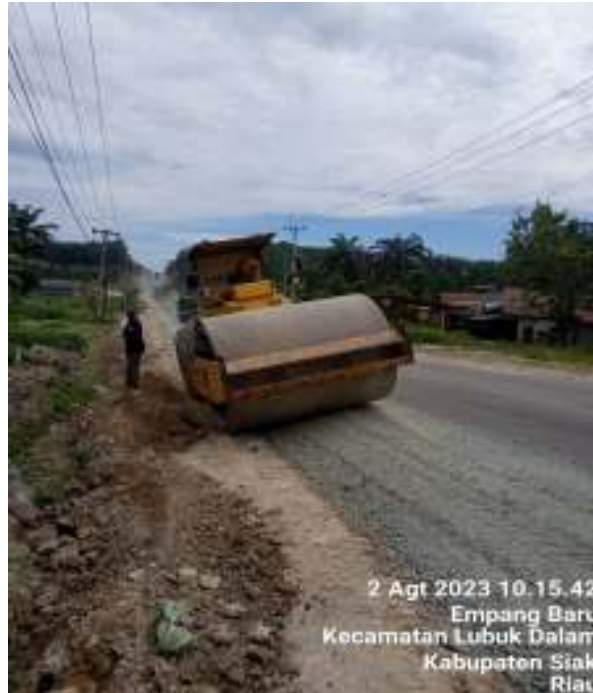
Gambar 3.18 Pematatan timbunan aggregate kelas A
