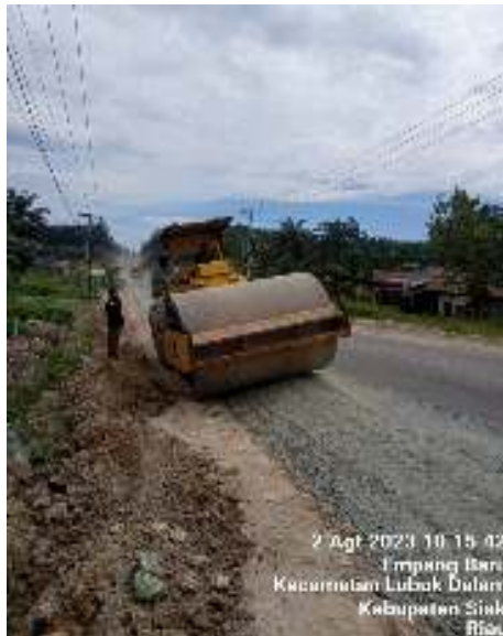
Gambar 4.9 vibrator roller untuk pemadatan base yang sudah dihamparkan
