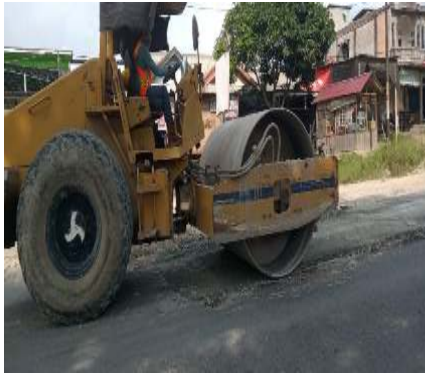
Gambar 3.24 Pemasangan Agregat kelas A
