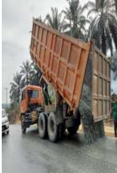
Gambar 4.10 untuk membawa base dari pangkalan koto baru
