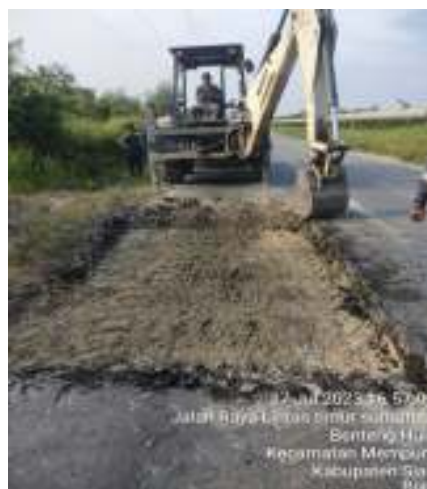
Gambar 3.19 Pembongkaran permukaan jalan yang rusak
