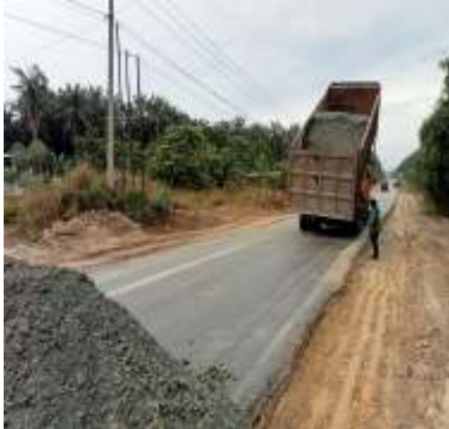
Gambar3.16 penuangan marerial agregat kelas A
