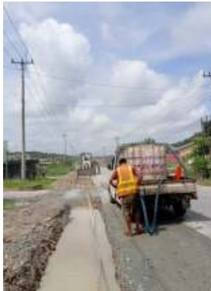
Gambar 4.11 untuk menyiram jalan yang berdebu
