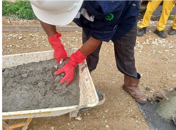
Gambar 4.12 Pengambilan sampel uji slump (Sumber: Dokumentasi Lapangan 2023)
