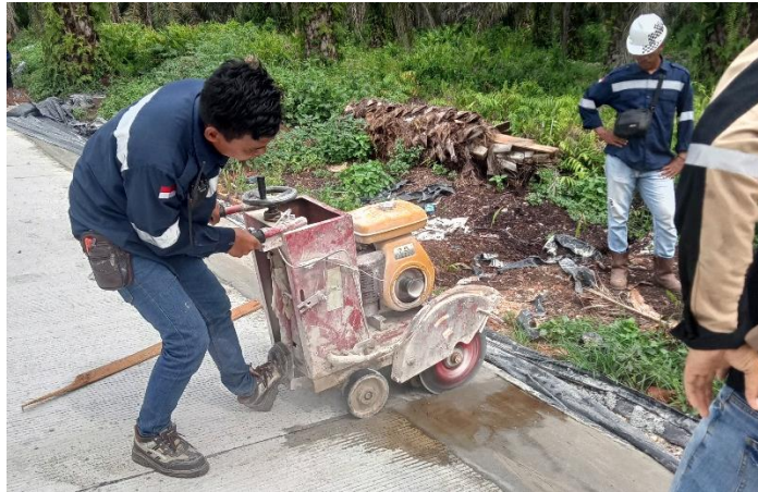
Gambar 3.34 Cutting Bahu Jalan Sumber: Dokumentasi Lapangan 2023
