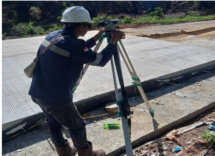
Gambar 4.9 Pengecekan Elevasi Bekisting LC (Sumber: Dokumentasi Lapangan 2023)
