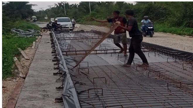
Gambar 3.15 Pekerjaan Pembesian Rigid (sumber : Dokumentasi Lapangan, Kerja Praktek 2023)
