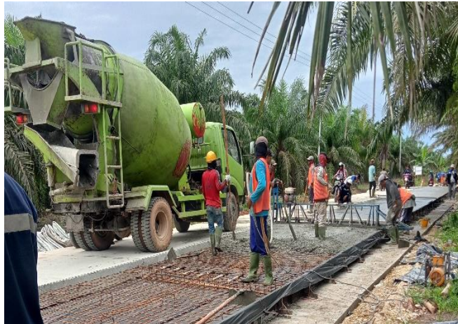
Gambar 2.8 Truck Mixer (Sumber: Dokumentasi Lapangan 2023)
