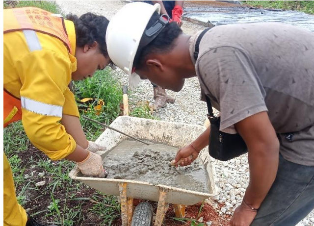
Gambar 4.18 Pengambilan Sampel beton Kubus (Sumber: Dokumentasi Lapangan 2023)
