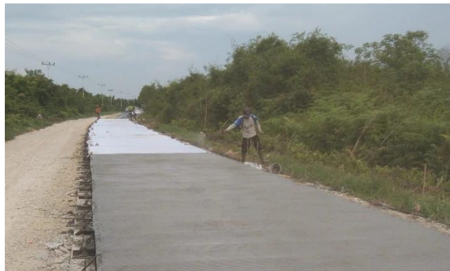
Gambar 3.23 Pekerjaan Curing Compound (sumber : Dokumentasi Lapangan, Kerja Praktek 2023)
