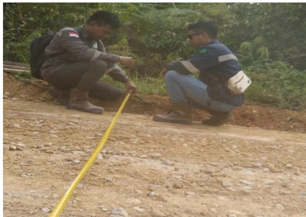
Gambar 4.5 Pengukuran Lebar untuk Bekisting LC ( Lean Concrete ) (Sumber: Dokumentasi Lapangan 2023)
