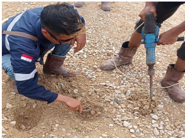
Gambar 3.3 Penggalian lubang Test Pit Base B (sumber : Dokumentasi Lapangan, Kerja Praktek 2023)
