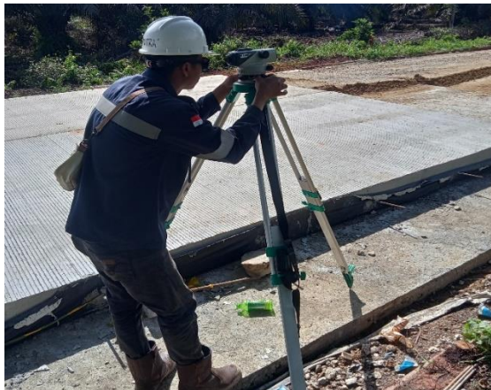
Gambar 3.9 Pegecekan Bekisting LC (sumber : Dokumentasi Lapangan, Kerja Praktek 2023)
