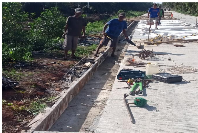
Gambar 3.27 Pemasangan Bekisting Sumber: Dokumentasi Lapangan 2023
