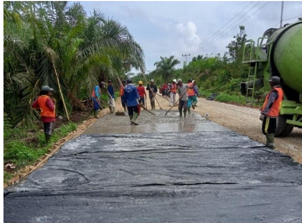
Gambar 3.10 Pengecoran LC (sumber : Dokumentasi Lapangan, Kerja Praktek 2023)
