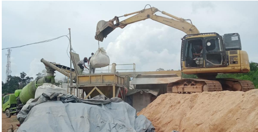
Gambar 4.10 Persiapan Beton Ready Mix (Sumber: Dokumentasi Lapangan 2023)
