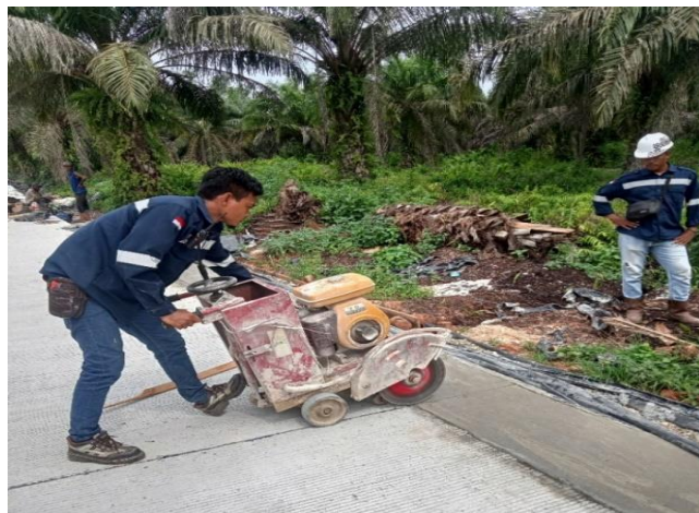
Gambar 3.25 Pekerjaan Cutting (sumber : Dokumentasi Lapangan, Kerja Praktek 2023)
