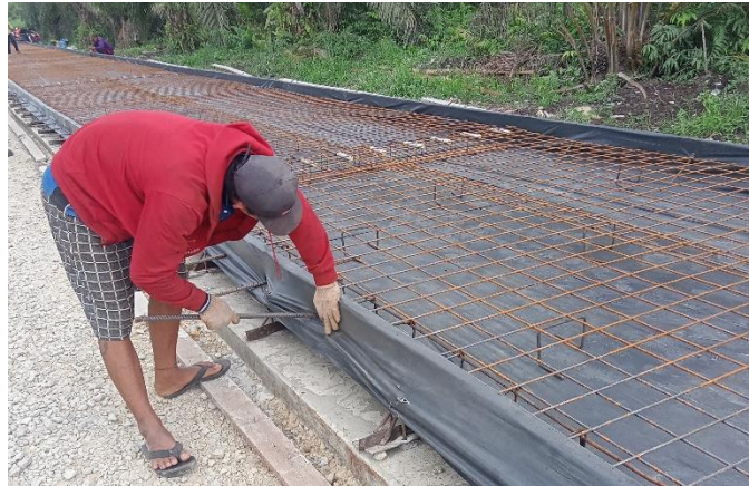
Gambar 3.16 Pemasangan Tie Bar (sumber : Dokumentasi Lapangan, Kerja Praktek 2023)
