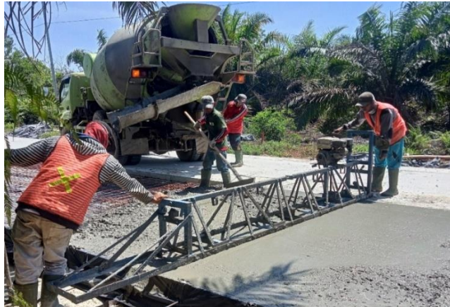
Gambar 3.20 Meratakan Permukaan Beton (sumber : Dokumentasi Lapangan, Kerja Praktek 2023)
