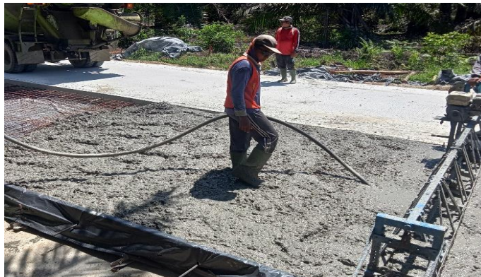
Gambar 3.19 Pemasangan Beton Menggunakan Vibrator (sumber : Dokumentasi Lapangan, Kerja Praktek 2023)
