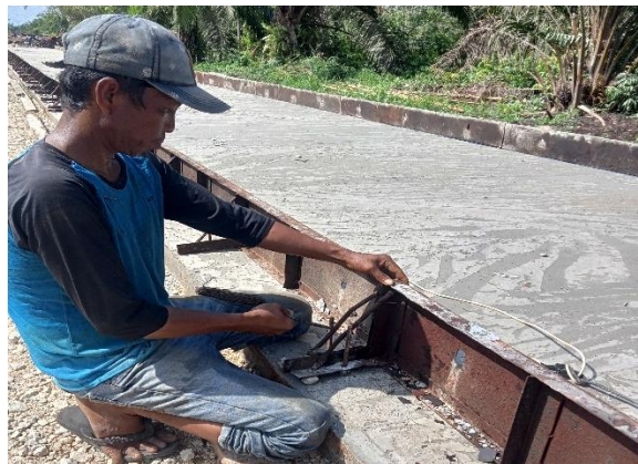
Gambar 3.13 Pengikatan Besi Penahan Bekisting Rigid (sumber : Dokumentasi Lapangan, Kerja Praktek 2023)
