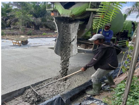
Gambar 3.31 Penuangan Beton Sumber: Dokumentasi Lapangan 2023
