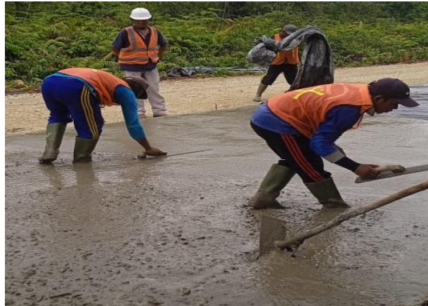
Gambar 4.24 Finishing/Meratakan permukaan beton LC (Sumber: Dokumentasi Lapangan 2023)
