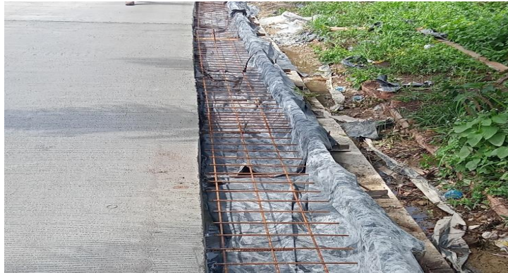
Gambar 3.28 Pemasangan Plastik dan Pembesian Sumber: Dokumentasi Lapangan 2023
