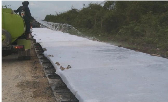
Gambar 3.24 Pekerjaan Perawatan Beton curing (sumber : Dokumentasi Lapangan, Kerja Praktek 2023)
