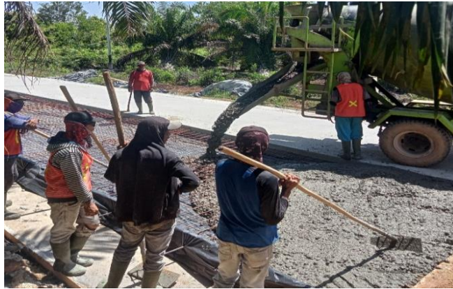
Gambar 3.18 Pengecoran Rigid (sumber : Dokumentasi Lapangan, Kerja Praktek 2023)
