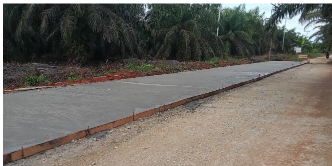
Gambar 4.26 Hasil Pengecoran LC (Sumber: Dokumentasi Lapangan 2023)
