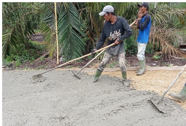
Gambar 4.23 Meratakan beton pengecoran LC (Sumber: Dokumentasi Lapangan 2023)
