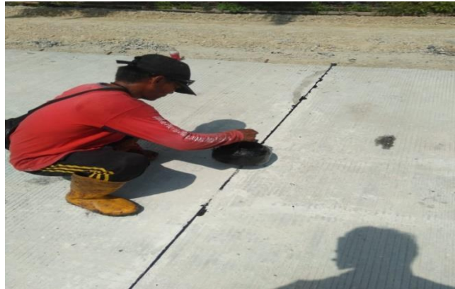
Gambar 3.26 Pekerjaan Joint Sealent (sumber : Dokumentasi Lapangan, Kerja Praktek 2023)
