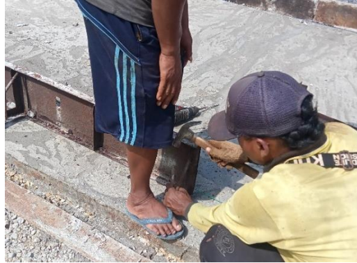
Gambar 3.12 Pemasangan Besi Penahan Bekisting Rigid (sumber : Dokumentasi Lapangan, Kerja Praktek 2023)
