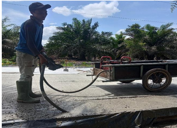
Gambar 3.32 Pematatan Beton Menggunakan Vibrator Sumber: Dokumentasi Lapangan 2023
