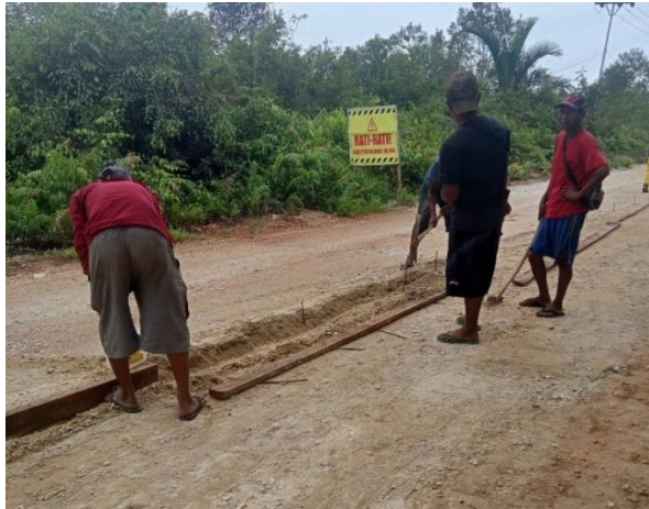
Gambar 3.8 Pemasangan Bekisting LC (sumber : Dokumentasi Lapangan, Kerja Praktek 2023)
