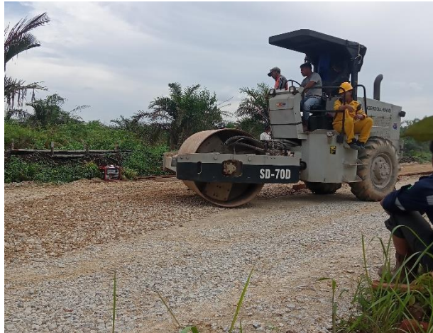
Gambar 3.2 Pemasadatan agregat base B (sumber : Dokumentasi Lapangan, Kerja Praktek 2023)
