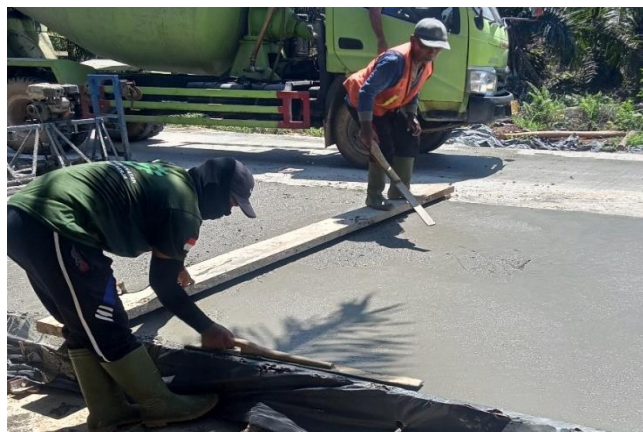
Gambar 3.21 Finishing (sumber : Dokumentasi Lapangan, Kerja Praktek 2023)
