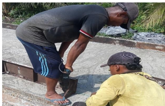
Gambar 3.11 Pengeboran LC untuk Pemasangan Besi Penahan Bekisting Rigid (sumber : Dokumentasi Lapangan, Kerja Praktek 2023)
