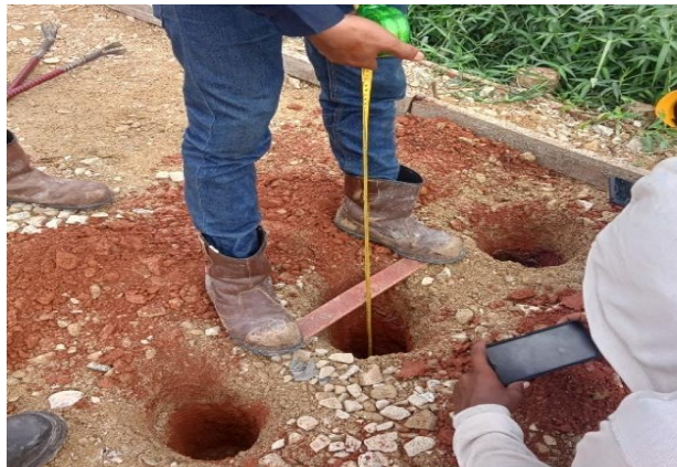
Gambar 3.5 Pengukuran Test Pit Tanah Timbunan (sumber : Dokumentasi Lapangan, Kerja Praktek 2023)
