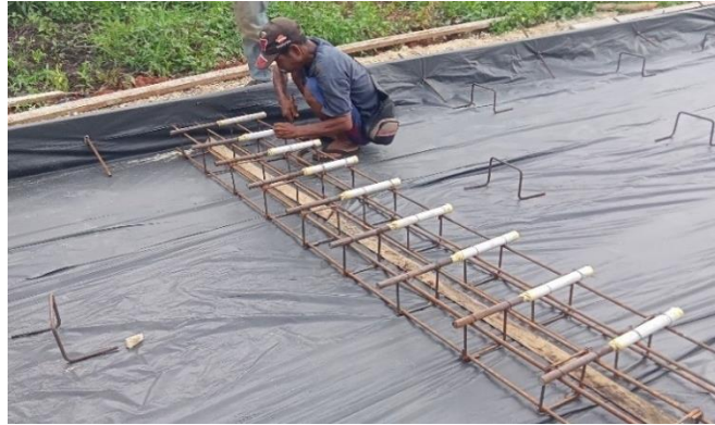
Gambar 3.14 Pemasangan Tulangan Dowel & Dudukan Wiremesh (sumber : Dokumentasi Lapangan, Kerja Praktek 2023)
