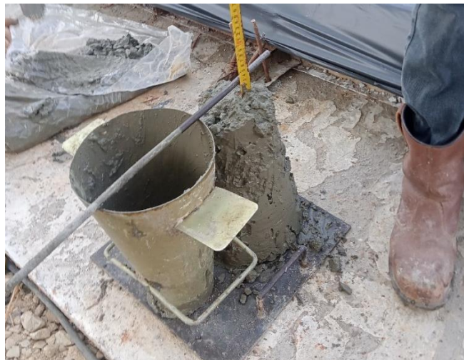
Gambar 3.35 Penujian Slump Test Sumber: Dokumentasi Lapangan 2023
