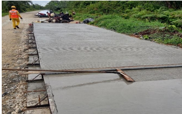
Gambar 3.22 Pekerjaan Grooving (sumber : Dokumentasi Lapangan, Kerja Praktek 2023)
