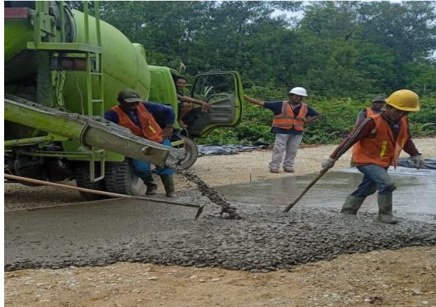
Gambar 4.22 Penuangan beton pengecoran LC (Sumber: Dokumentasi Lapangan 2023)
