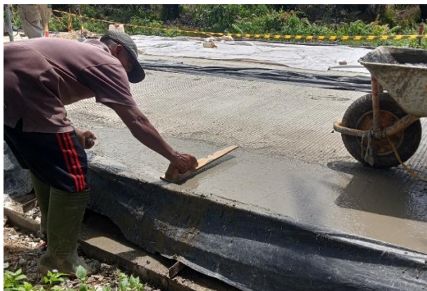
Gambar 3.33 Proses Perataan Beton Atau Finishing Sumber: Dokumentasi Lapangan
