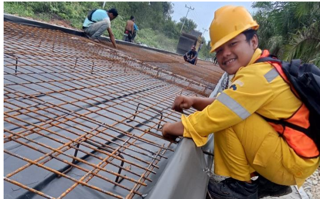
Gambar 3.17 Pengikatan Besi Tulangan (sumber : Dokumentasi Lapangan, Kerja Praktek 2023)
