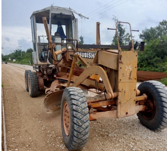
Gambar 3.1 Perataan agregat base B (sumber : Dokumentasi Lapangan, Kerja Praktek 2023)
