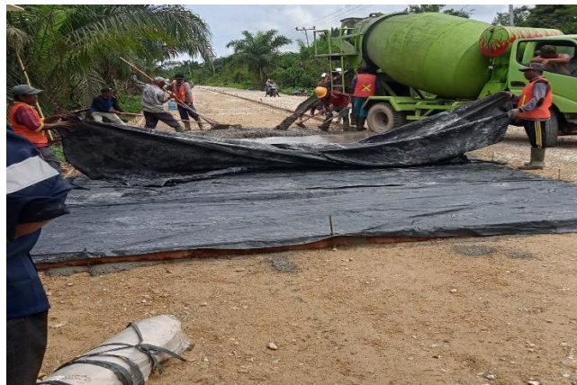
Gambar 4.25 Pemasangan plastik pelindung untuk LC (Sumber: Dokumentasi Lapangan 2023)
