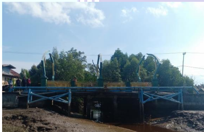
Gambar 1.1 Jembatan Sungai Bengkalis (Sumber: Dokumentasi lapangan, 2020)
