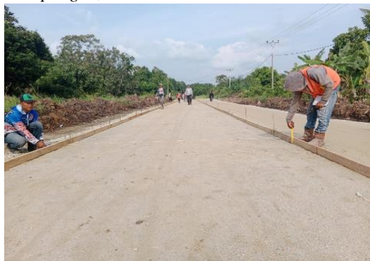
Gambar 4.10 Pemasangan bekisting LC Sumber :Dokumentasi Lapangan, 2023
