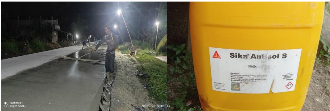
Gambar 3.17 Penyemprotan Curing Compound Sumber: Dokumentasi Lapangan, 2023
