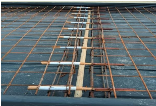
Gambar 3.9 Pemasangan crack inducer dan dudukan dowel Sumber :Dokumentasi Lapangan, 2023
