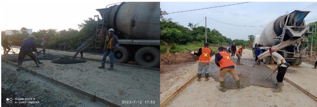
Gambar 3.6 Pekerjaan Pengecoran Lean Concrete Sumber: Dokumentasi Lapangan, 2023
