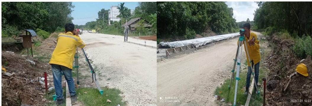
Gambar 3.1 pembacaan levelling base menggunakan waterpass Sumber: Dokumentasi Lapangan, 2023
