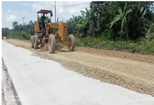
Gambar 3.23 Penurunan menggunakan Base Motor Grader Sumber : Dokumentasi Lapangan, 2023
