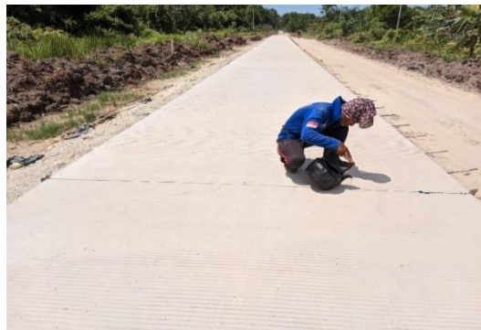
Gambar 3.20 Penuangan Joint Sealant Sumber : Dokumentasi Lapangan, 2023
