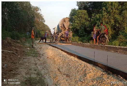
Gambar 4.16 Hasil Pengecoran LC Sumber :Dokumentasi Lapangan, 2023
