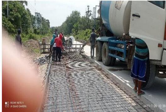
Gambar 3.12 Pengecoran rigid Sumber: Dokumentasi Lapangan, 2023
