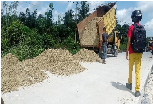
Gambar 3.22 Penghamparan base bahu jalan Sumber : Dokumentasi Lapangan, 2023
