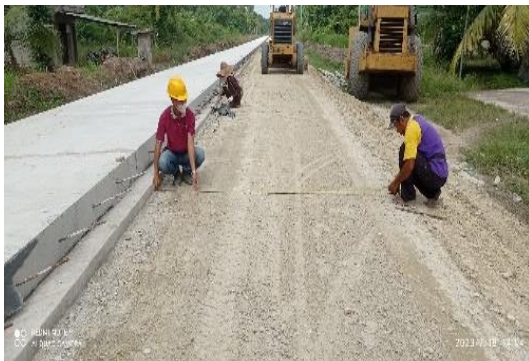
Gambar 4.8 Pengukuran lebar patok lc Sumber :Dokumentasi Lapangan, 2023
