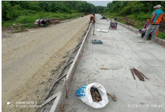
Gambar 3.4 Pemasangan Bekisting Rigid Sumber: Dokumentasi Lapangan, 2023
