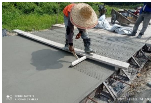
Gambar 3.16 Pembuatan Tekstur ( Grooving ) Sumber: Dokumentasi Lapangan, 2023
