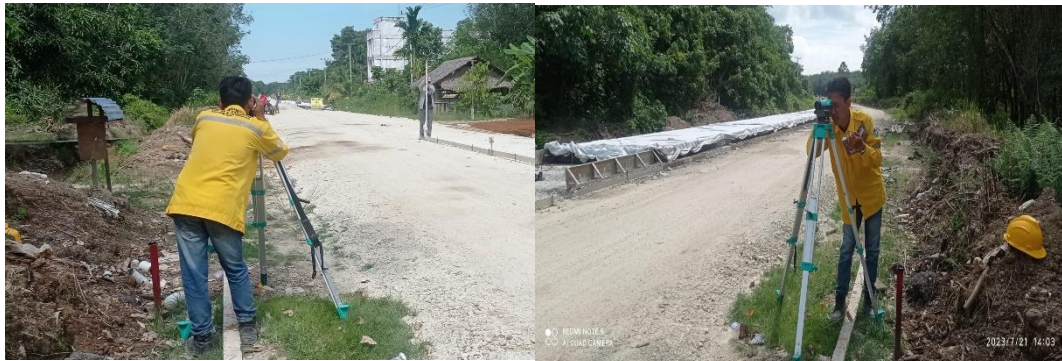
Gambar 4.6 pembacaan levelling base menggunakan waterpass Sumber: Dokumentasi Lapangan, 2023
