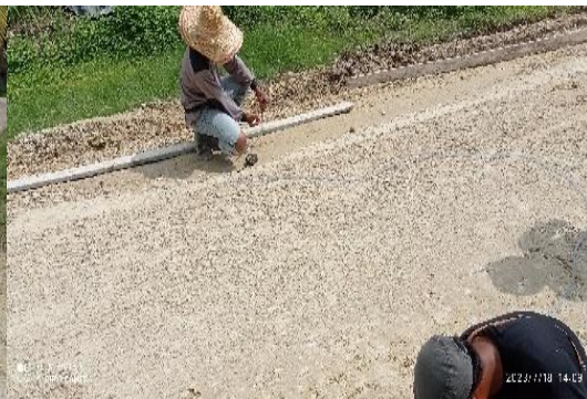
Gambar 4.9 Pengukuran timbang air Sumber :Dokumentasi Lapangan, 2023
