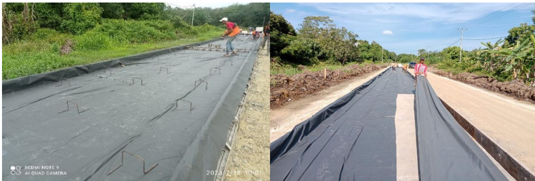
Gambar 3.8 Pemasangan Plastik Alas Sumber: Dokumentasi Lapangan, 2023
