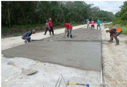
Gambar 4.15 Perataan Beton lc Sumber: Dokumentasi Lapangan, 2023
