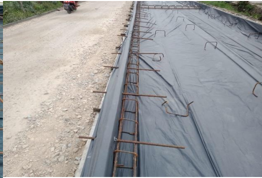
Gambar 3.10 pemasangan dudukan Tiebar Sumber :Dokumentasi Lapangan, 2023
