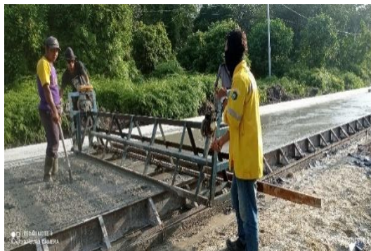
Gambar 3.14 Pemerataan permukaan Rigid menggunakan concrete truss screed Sumber: Dokumentasi Lapangan, 2023
