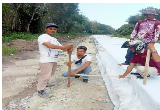
Gambar 3.21 Proses pemasangan patok bahu jalan Sumber : Dokumentasi Lapangan, 2023
