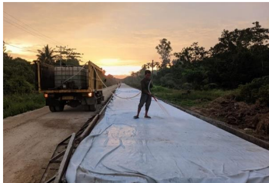
Gambar 3.19 Penyiraman Air Pada Rigid SumberDokumentasi Lapangan, 2023
