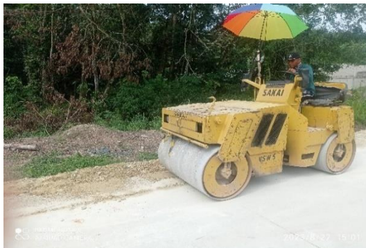
Gambar 3.24 Pemasakan bahu jalan Sumber : Dokumentasi Lapangan, 2023
