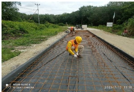
Gambar 3.11 Pemasangan wiremesh Sumber :Dokumentasi Lapangan, 2023
