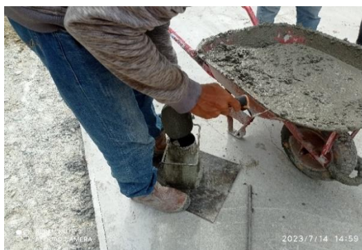
Gambar 4.12 Pengujian Slump Sumber :Dokumentasi Lapangan, 2023
