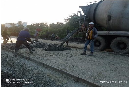
Gambar 4.14 Penuangan Beton ditempat yang akan di cor Sumber: Dokumentasi Lapangan, 2023
