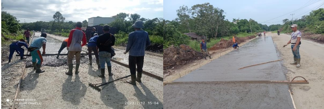
Gambar 3.7 Proses perataan lc Sumber: Dokumentasi Lapangan, 2023
