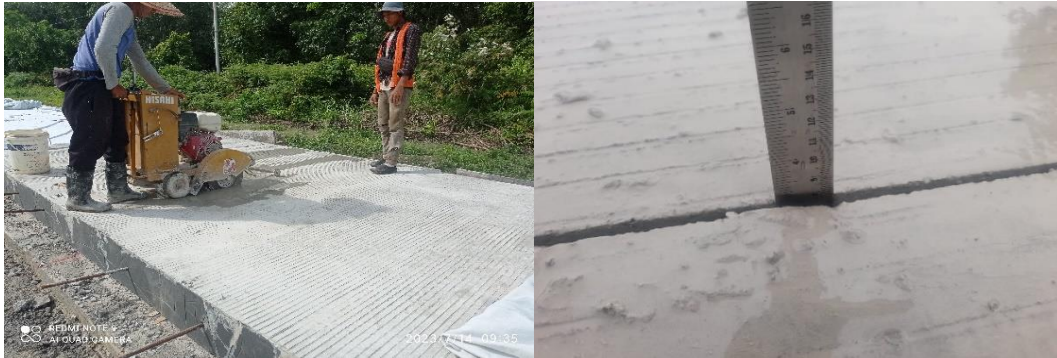
Gambar 3.18 Pekerjaan Cutting Sumber: Dokumentasi Lapangan, 2023
