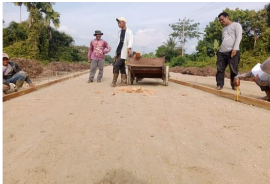
Gambar 3.3 Pemasangan Bekisting Lean Concrete Sumber: Dokumentasi Lapangan, 2023
