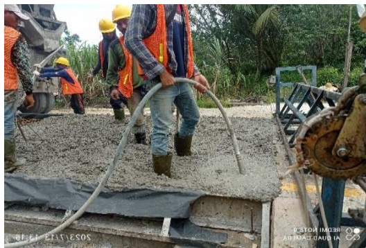
Gambar 3.13 Pemasangan Rigid menggunakan mesin vibro Sumber: Dokumentasi Lapangan, 2023
