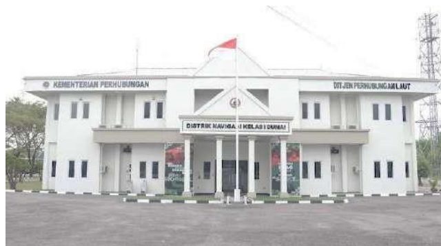
Gambar 1.1.3. Kantor Distrik Navigasi Kelas I Dumai
