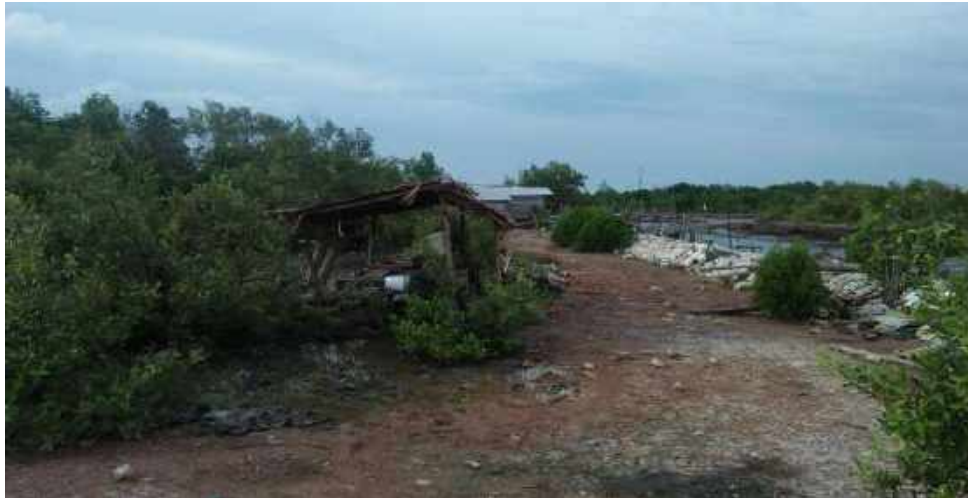
Gambar 1.2 Kondisi eksisting muara sungai Bengkalis Sumber: Dokumentasi Lapangan .2020
