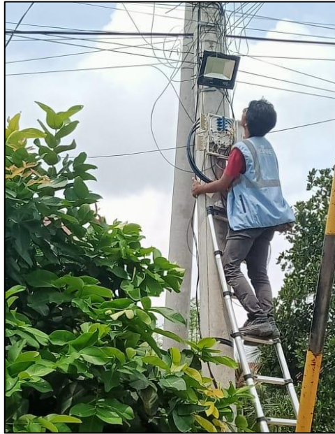
Gambar 3. 8 Perbaikan jaringan pelanggan
