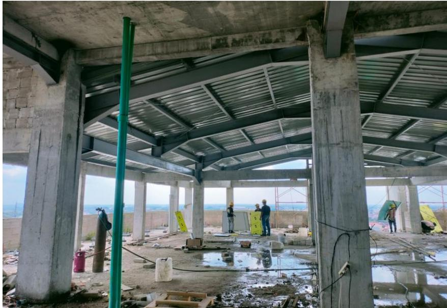
*Gambar 3 Pekerjaan pemasangan atap*
