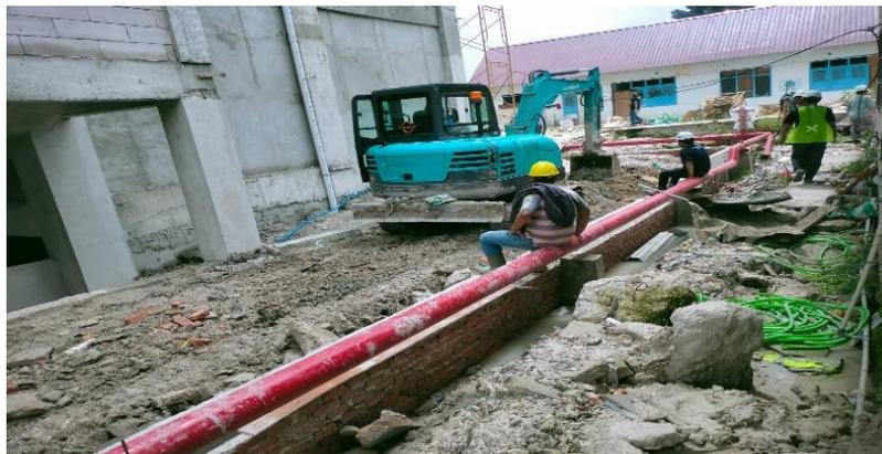
*Gambar 5 Pemasangan pipa air bersih & kotor*
