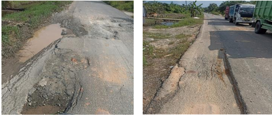
Gambar 1.1 Jalan Sultan Syarif Kasim Sepanjang 1 Km Desa Teluk Masjid Kecamatan Sungai Apit Kabupaten Siak (Sumber: Dokumentasi Lapangan)
