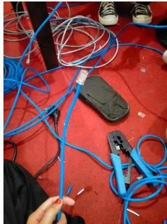
Gambar 3. 7 Pembuatan kabel LAN (Sumber: Dokumentasi pribadi, 2024)
