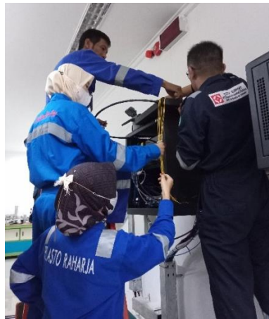
Gambar 3. 8 Melakukan terminasi fiber optic (Sumber: Dokumentasi pribadi, 2024)
