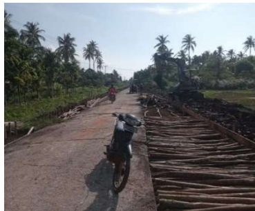
Gambar 3. 10 Dokumentasi Pemasangan Gambangan (Sumber: Dokumentasi KP penulis,2023)
