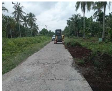
Gambar 3. 8 Dokumentasi Pembersihan Lahan (Sumber: Dokumentasi KP penulis,2023)
