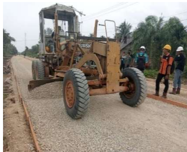
Gambar 4. 3 Proses Perataan Base B Sumber: Dokumentasi KP penulis, 2023
