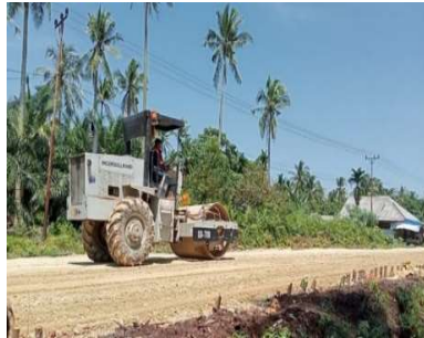
Gambar 3. 14 Dokumentasi Pemadatan Base B (Sumber: Dokumentasi KP penulis,2023)
