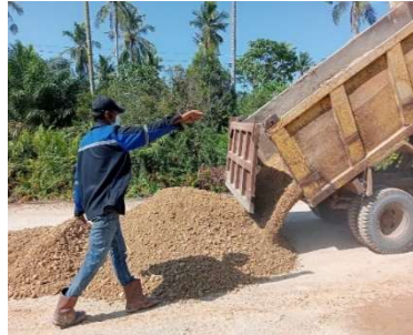
Gambar 4. 2 Proses Penuangan Base B (Sumber: Dokumentasi KP penulis, 2023)
