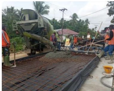
Gambar 3. 22 Dokumentasi Pengecoran Rigid (Sumber: Dokumentasi KP penulis,2023)
