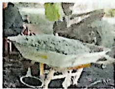
Gerobak sorong yang terisi campuran beton
