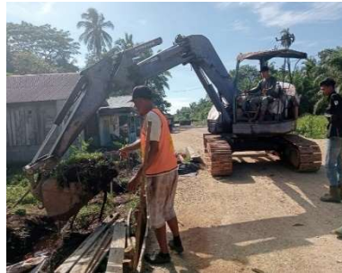
Gambar 3. 9 Dokumentasi Penggalian Lahan (Sumber: Dokumentasi KP penulis,2023)
