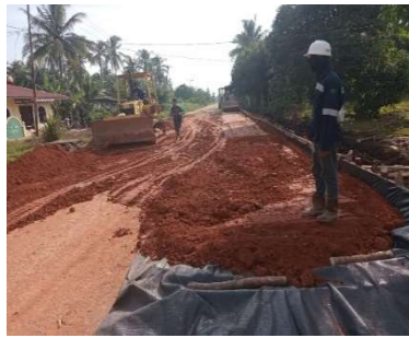
Gambar 3. 12 Dokumentasi Timbunan Pilihan (Sumber: Dokumentasi KP penulis,2023)
