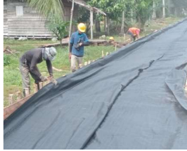
Gambar 3. 11 Dokumentasi Pemasangan Geotex Woven (Sumber: Dokumentasi KP penulis,2023)
