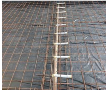
Gambar 3. 21 Dokumentasi Penulangan Rigid
