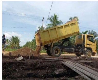
Gambar 3. 13 Dokumentasi Penghamparan Base B (Sumber: Dokumentasi KP penulis,2023)
