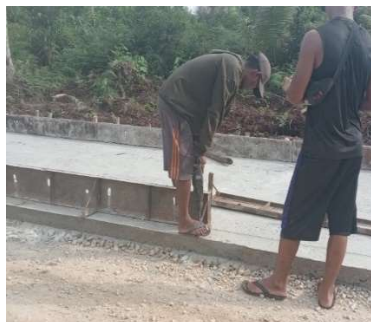
Gambar 3. 20 Dokumentasi Pemasangan Mal Rigid (Sumber: Dokumentasi KP penulis,2023)
