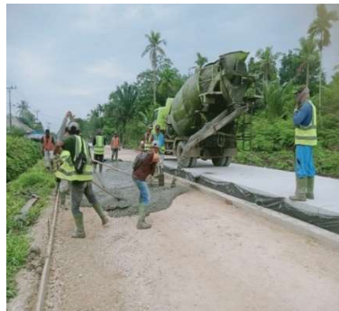
Gambar 3. 19 Dokumentasi Pengecoran LC Sumber: Dokumentasi KP penulis,2023
