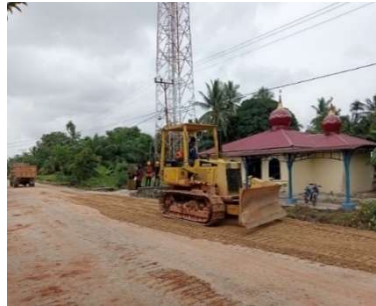
Gambar 3. 6 Gambar Dozer (Sumber: Dokumentasi KP penulis,2023)
