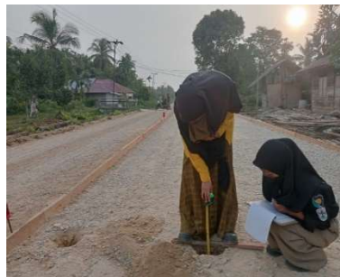
Gambar 4. 7 Pengukuran Ketebalan Base B (Sumber: Dokumentasi KP penulis, 2023)
