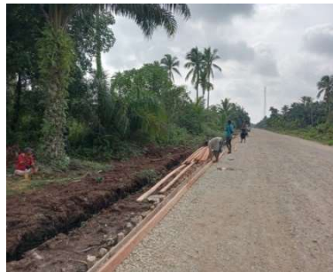
Gambar 3. 18 Dokumentasi Pemasangan LC (Sumber: Dokumentasi KP penulis,2023)
