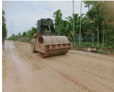
Gambar 4. 5 Proses Pemadatan Base B (Sumber: Dokumentasi KP penulis, 2023)
