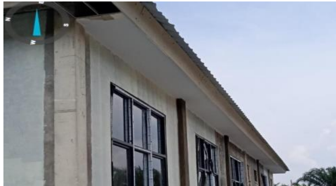
Gambar 3.25 Pemasangan plafond piri-piri GRC Sumber; Dokumentasi Pribadi dilokasi proyek
