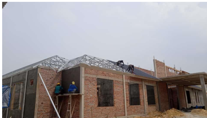
Gambar 3.16 Pemasangan atap spandek Sumber; Dokumentasi Pribadi dilokasi proyek
