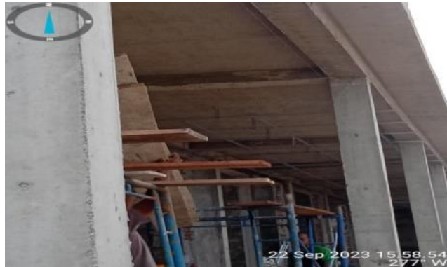
Gambar 3.20 Pemasangan rangka plafond utama Sumber; Dokumentasi Pribadi dilokasi proyek
