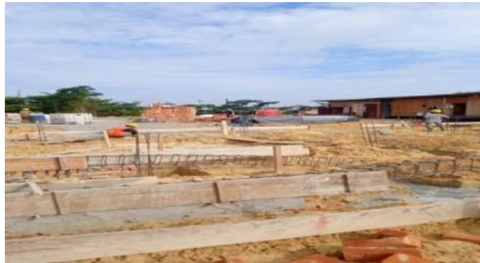
Gambar 3.2 Pemasangan tulangan dan bekisting Sumber; Dokumentasi Pribadi dilokasi proyek
