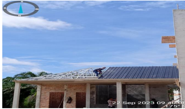
Gambar 3.17 Pemasangan atap spandek aula Sumber; Dokumentasi Pribadi dilokasi proyek
