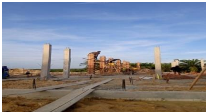
Gambar 3.5 Pengecoran dan pembongkaran bekisting kolom Sumber; Dokumentasi Pribadi dilokasi proyek
