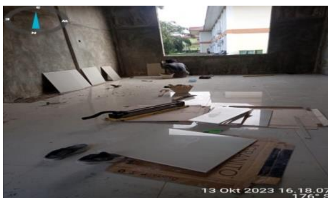
Gambar 3.30 Pemaangan granit 60x60cm utama Sumber; Dokumentasi Pribadi dilokasi proyek
