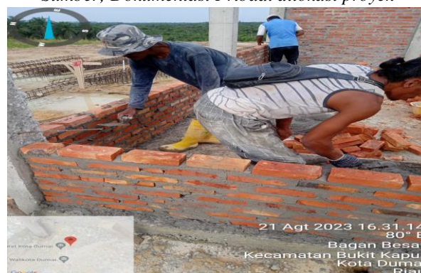
Gambar 3.11 Pemasangan batu bata utama Sumber; Dokumentasi Pribadi dilokasi proyek
