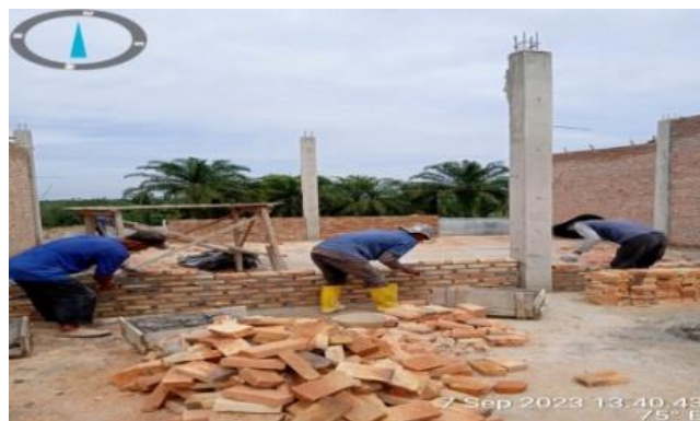
Gambar 3.11 Pemasangan batu bata utama Sumber; Dokumentasi Pribadi dilokasi proyek
