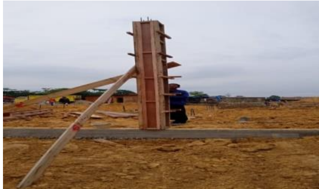
Gambar 3.4 Tulangan dan bekisting Sumber; Dokumentasi Pribadi dilokasi proyek
