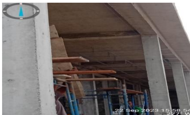
Gambar 3.10 Pembongkaraan dak beton teras dalam Sumber; Dokumentasi Pribadi dilokasi proyek
