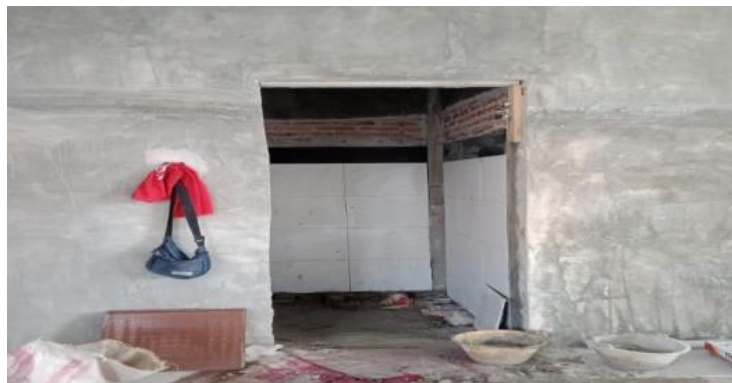
Gambar 3.33 Pemasangan keramik dinding 40x40cm dan 20x40cm Sumber; Dokumentasi Pribadi dilokasi proyek
