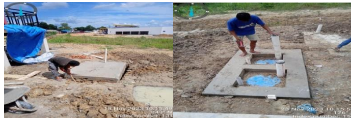
Gambar 3.38 Pekerjaan saptictank Sumber; Dokumentasi Pribadi di lokasi proyek
