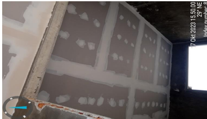
Gambar 3.23 Pemaangan plafond Gypsum aula Sumber; Dokumentasi Pribadi dilokasi proyek
