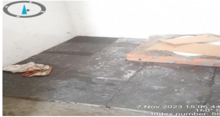
Gambar 3.32 Pemasangan keramis toilet 40x40cm Sumber; Dokumentasi Pribadi dilokasi proyek
