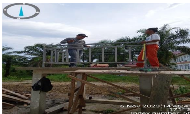
Gambar 3.41 Pekerjaan pengecoran sloof dan pemasangan kolom Sumber; Dokumentasi Pribadi di lokasi proyek
