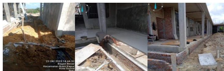
Gambar 3.39 Pekerjaan rabat dan dranse Sumber; Dokumentasi Pribadi di lokasi proyek
