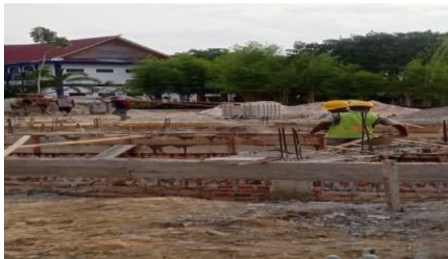
Gambar 3.3 Pengecoran sloof Sumber; Dokumentasi Pribadi dilokasi proyek.
