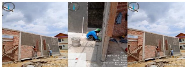
Gambar 3.13 Plasteraan dan acian dinding Sumber; Dokumentasi Pribadi di lokasi
