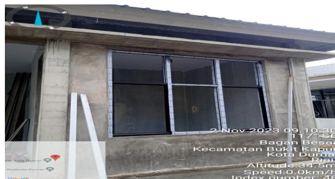
Gambar 3.19 Pemasangan Listplank GRC Sumber; Dokumentasi Pribadi dilokasi proyek
