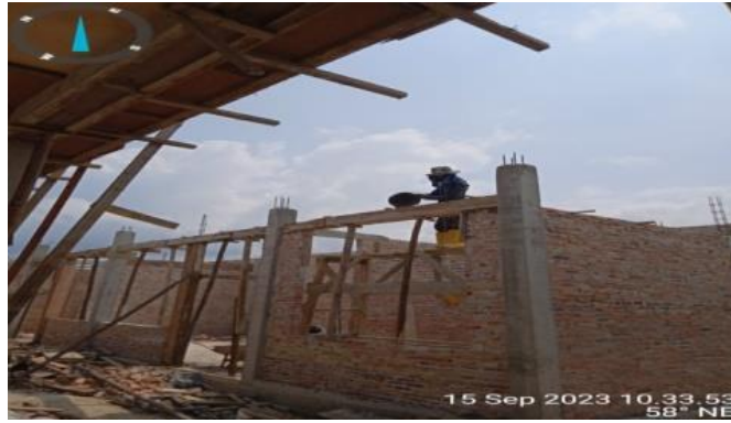
Gambar 3.8 Pengecoran dan pembongkaran bekisting balok latei Sumber; Dokumentasi Pribadi dilokasi proyek
