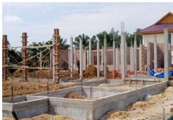
Gambar 3.28 Urungan tanah bawah lantai Sumber; Dokumentasi Pribadi dilokasi proyek
