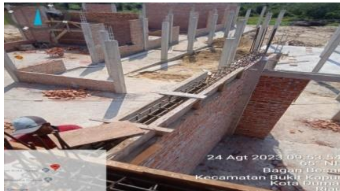
Gambar 3.6 Tulangan dan bekisting ring balok bekisting Sumber; Dokumentasi Pribadi dilokasi proyek
