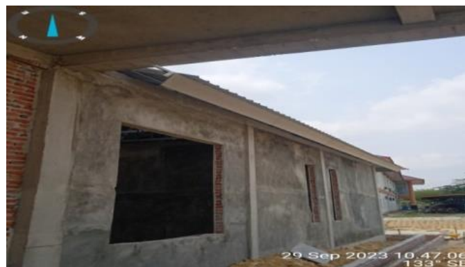
Gambar 3.18 Pemasangan Listplank GRC Sumber; Dokumentasi Pribadi dilokasi proyek
