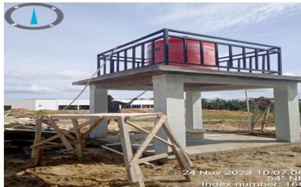
Gambar 3.43 Pekerjaan pengecatan manara air Sumber; Dokumentasi Pribadi di lokasi proyek
