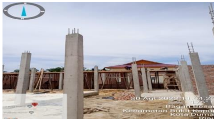
Gambar 3.7 Pengecoran dan pembongkaran bekisting ring balok Sumber; Dokumentasi Pribadi dilokasi proyek
