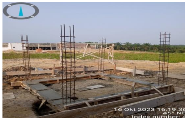
Gambar 3.41 Pekerjaan pengecoran sloof dan pemasangan kolom Sumber; Dokumentasi Pribadi di lokasi proyek
