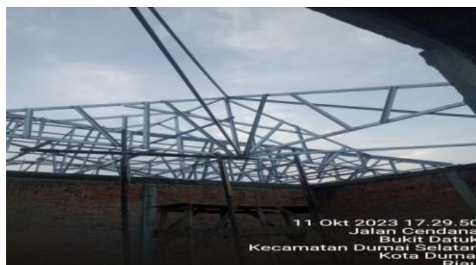
Gambar 3.14 Rangka kuda-kuda baja ringan utama Sumber; Dokumentasi Pribadi di lokasi proyek
