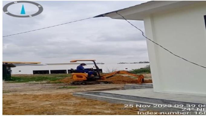
Gambar 3.45 Pekerjaan sumur bor Sumber; Dokumentasi Pribadi di lokasi proyek
