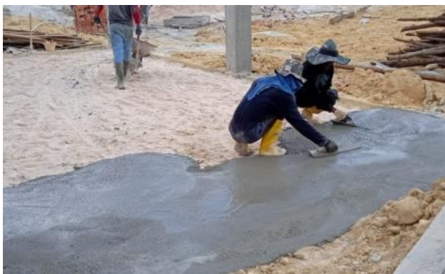
Gambar 3.29 Pasir bawah lantai dan pengecoran lantai Sumber; Dokumentasi Pribadi dilokasi proyek
