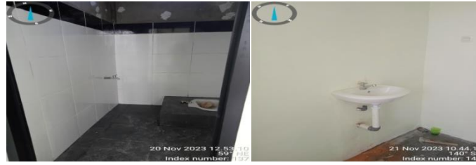
Gambar 3.37 Pekerjaan pemasangan kloset dan washtafel Sumber; Dokumentasi Pribadi di lokasi proyek
