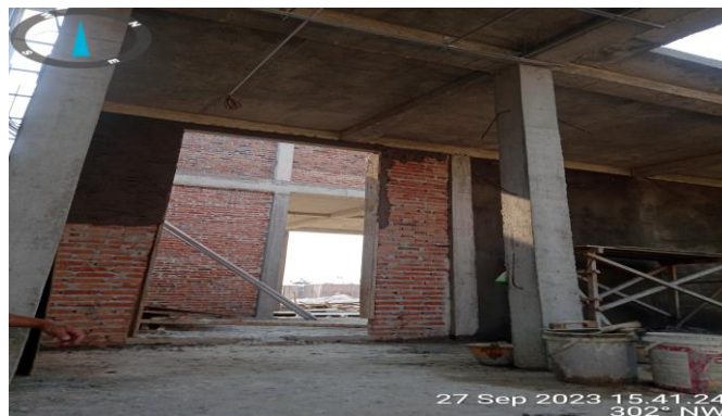
Gambar 3.21 Pemasangan rangka plafond aula Sumber; Dokumentasi Pribadi dilokasi proyek
