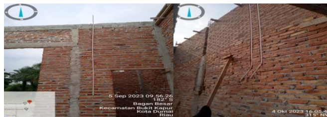
Gambar 3.35 Pekerjaan instalasi Sumber; Dokumentasi Pribadi dilokasi proyek
