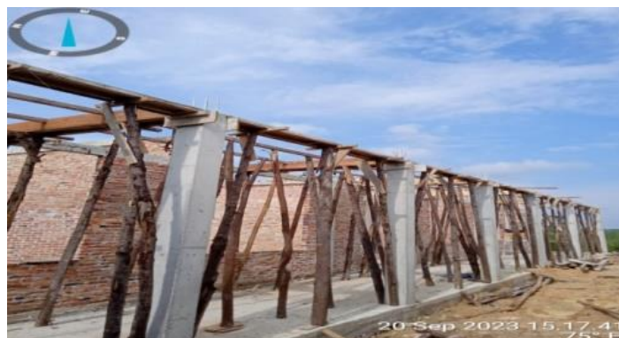
Gambar 3.9 Bekisting dak beton teras dalam Sumber; Dokumentasi Pribadi dilokasi proyek
