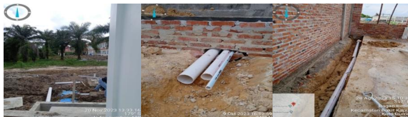
Gambar 3.36 Pekerjaan pemasangan pipa Sumber; Dokumentasi Pribadi dilokasi proyek
