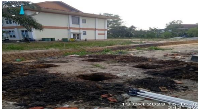
Gambar 3.40 Pekerjaan galian tanah manara air Sumber; Dokumentasi Pribadi di lokasi proyek
