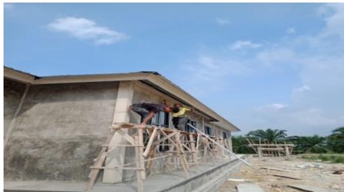
Gambar3.24 Pemaangan rangka piri-piri GRC Sumber; Dokumentasi Pribadi dilokasi proye
