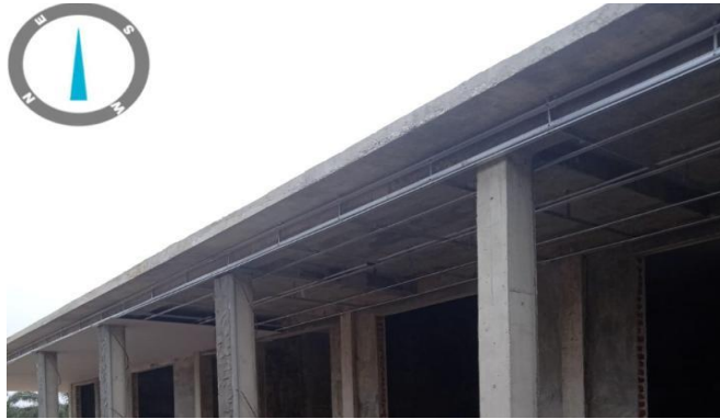
Gambar 3.22 Pemaangan plafond Gypsum utma Sumber; Dokumentasi Pribadi dilokasi proyek
