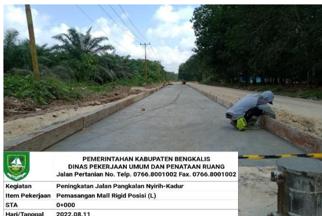
Gambar 3.8 Pemasangan Bekisting Rigid (Sumber : Dokumentasi Lapangan)
