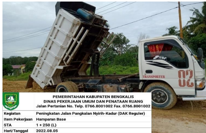
Gambar 3.1 Penuangan Base B (Sumber : Dokumentasi Lapangan)
