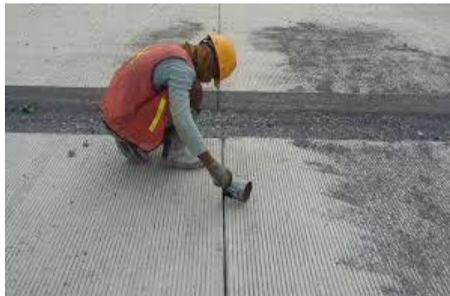
Gambar 3.16 Joint Sealant (Sumber : Dokumentasi Lapangan)
