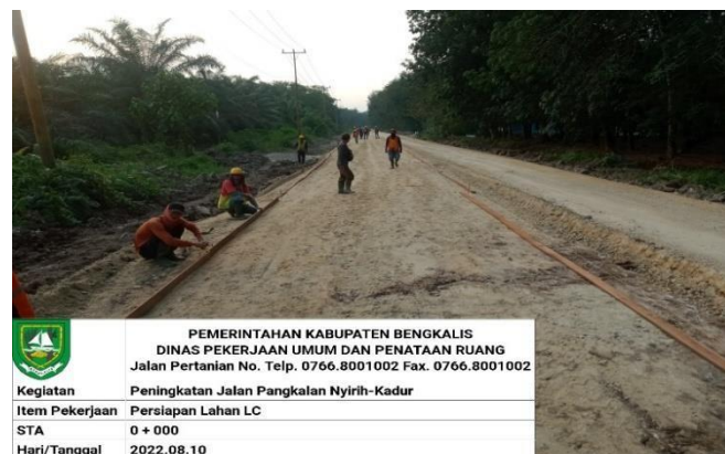
Gambar 4.6 Pemasangan Bekisting Lc (Sumber : Dokumentasi Lapangan)
