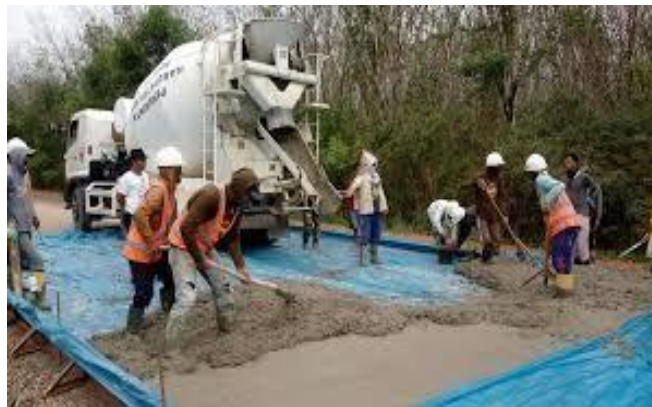
Gambar 3.7 Pengecoran Lc (Sumber : Dokumentasi Lapangan)
