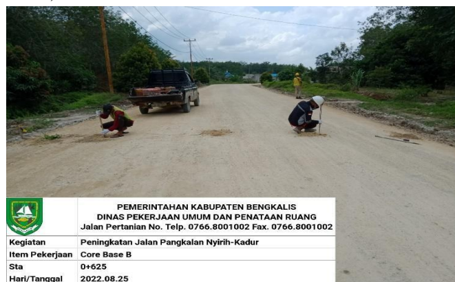
Gambar 3.4 Penge-core-an Base B (Sumber : Dokumentasi Lapangan)
