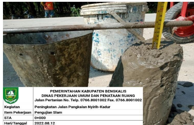
Gambar 4.8 Slump Test (Sumber : Dokumentasi Lapangan)
