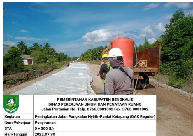
Gambar 2.7 Truck Pengangkut Air (Sumber: Dokumentasi Lapangan)
