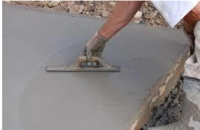
Gambar 4.11 Finishing Beton Lc (Sumber : Dokumentasi Lapangan )
