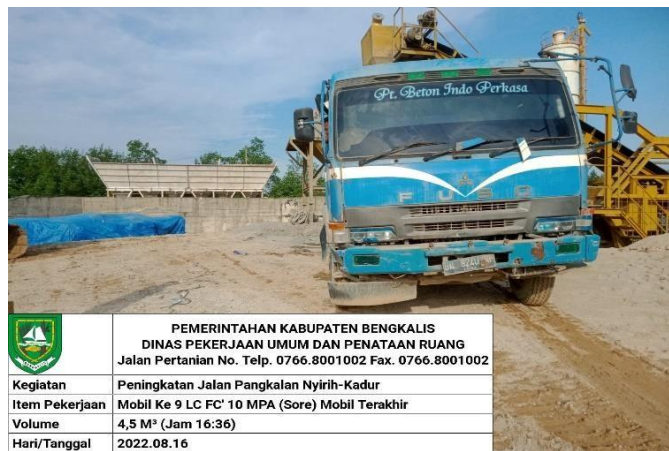
Gambar 4.7 Truck Mixer (Sumber : Dokumentasi Lapangan)
