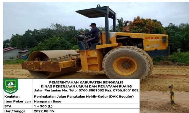
Gambar 3.3 Pematatan Base B (Sumber : Dokumentasi Lapangan)
