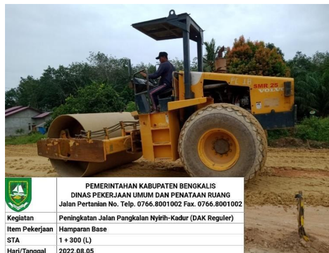
Gambar 2.5 Vibratory Roller (Sumber: Dokumentasi Lapangan)
