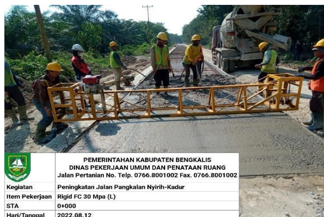
Gambar 3.11 Pengecoran Beton Rigid (Sumber : Dokumentasi Lapangan)
