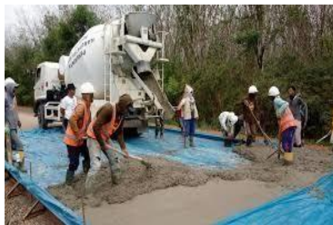
Gambar 4.10 PengecoranmLc (Sumber : Dokumentasi Lapangan)
