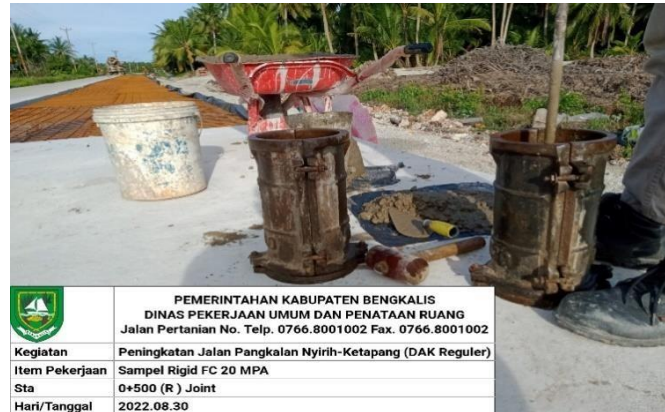
Gambar 4.9 Pembuatan Sampel Silinder (Sumber : Dokumentasi Lapangan)
