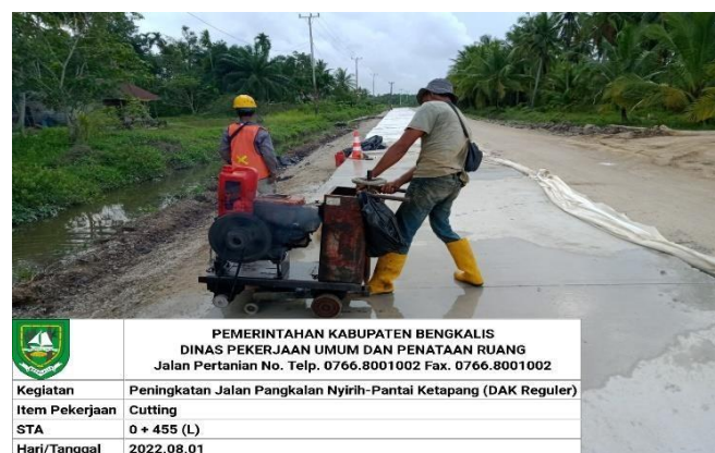
Gambar 3.15 Pemotongan Beton ( Cutting ) (Sumber : Dokumentasi Lapangan)
