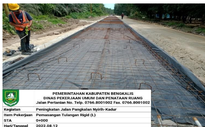
Gambar 3.10 Pemasangan Wiremesh (Sumber : Dokumentasi Lapangan)
