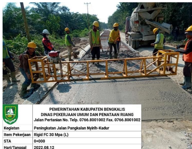
Gambar 2.9 Concrete Truss Screed (Sumber: Dokumentasi Lapangan)
