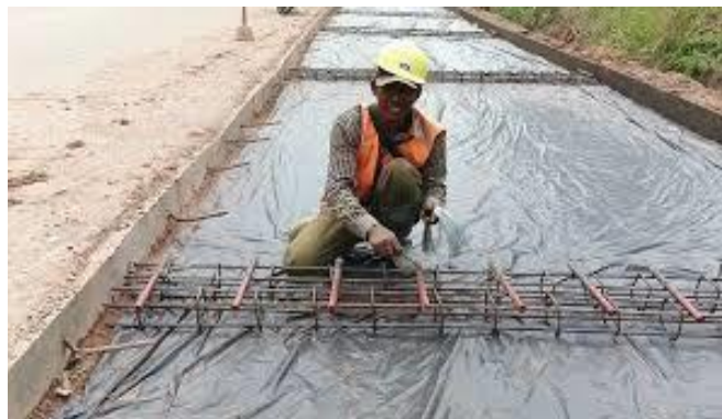
Gambar 3.9 Pemasangan Dowl dan Dudukan Wiremesh (Sumber : Dokumentasi Lapangan)
