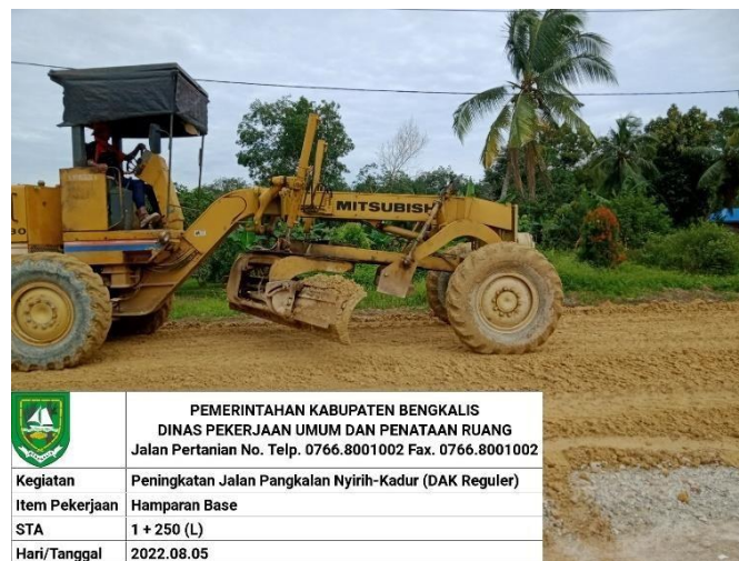
Gambar 3.2 Penghamparan Base B (Sumber : Dokumentasi Lapangan)
