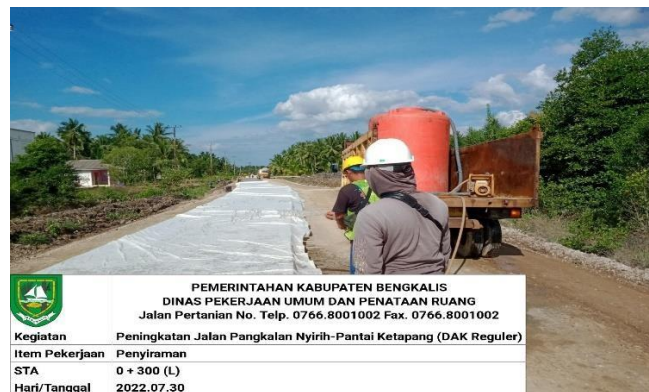
Gambar 3.14 Penyiraman Air pada Beton (Sumber : Dokumentasi Lapangan)
