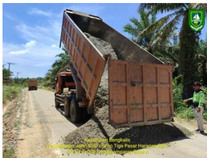
Gambar 3.2.6. pengangkutan menggunakan dump truck (Sumber: Dokumentasi Lapangan Kerja Praktek 2023)
