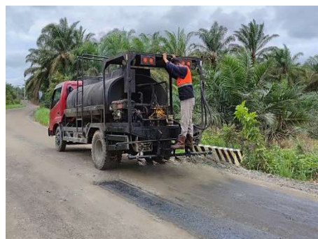
Gambar 3.2.15. Penyemprotan Prime Coat (Lapis resap) (Sumber: Dokumentasi Lapangan Kerja Praktek 2023)
