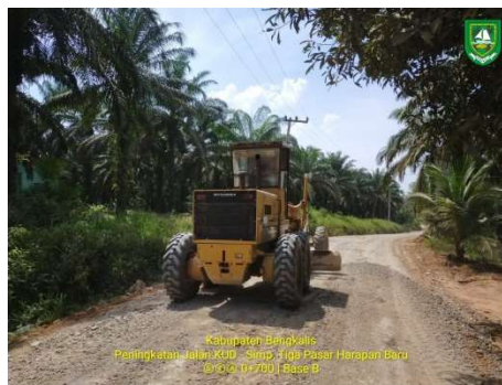
Gambar 3.2.2. Penghamparan Base B (Sumber: Dokumentasi Lapangan Kerja Praktek 2023)
