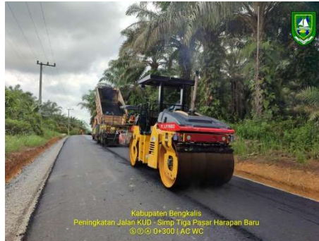
Gambar 3.1.22. Pematatan Menggunakan Tandem Roller (Sumber: Dokumentasi Lapangan Kerja Praktek 2023)
