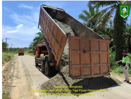
Gambar 4.3.1. pengangkutan menggunakan dump truck (Sumber: Dokumentasi Lapangan Kerja Praktek 2023)
