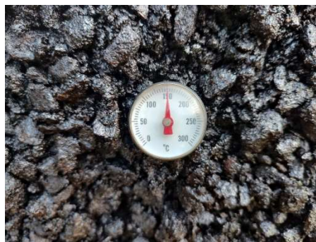
Gambar 3.2.18. Pengecekan Suhu Hampar Lapis Aus (AC-BC) (Sumber: Dokumentasi Lapangan Kerja Praktek 2023)
