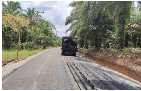
Gambar 3.2.17. Penyemprotan Tack Coat (Lapis resap) (Sumber: Dokumentasi Lapangan Kerja Praktek 2023)
