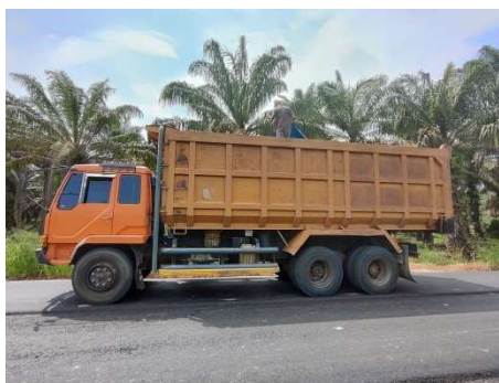
Gambar 3.2.16. Mobilisasi Laston Lapis Aus (AC-WC) (Sumber: Dokumentasi Lapangan Kerja Praktek 2023)
