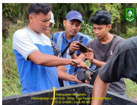
Gambar 3.1.23. Pengukuran Sampel Laston Lapis Aus (AC-BC) (Sumber: Dokumentasi Lapangan Kerja Praktek 2023)
