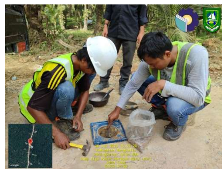
Gambar 3.2.5. Pekerjaan Sand Cone (Sumber: Dokumentasi Lapangan Kerja Praktek 2023)
