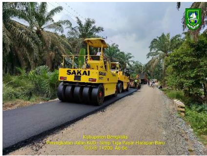
Kabupaten Bangkalis Peningkatan Jalan KUD - Simpang Pasir Hicap Baru 3/9/21 14:02 AC-BC
