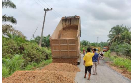
Gambar 3.2.11. pengangkutan menggunakan dump truck (Sumber: Dokumentasi Lapangan Kerja Praktek 2023)
