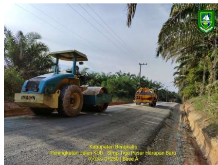
Gambar 3.2.8. pemadatan menggunakan vibro roller (Sumber: Dokumentasi Lapangan Kerja Praktek 2023)
