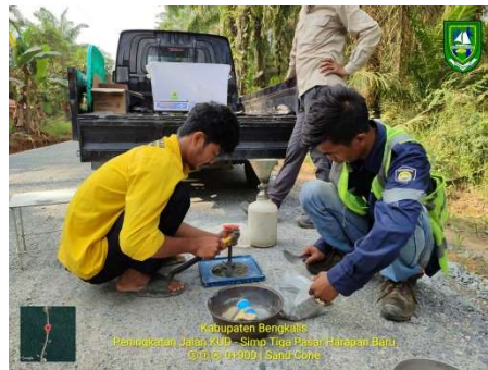
Gambar 4.14 Pengujian Sand Cone Test (Sumber : Dokumentasi KP, 2023)
