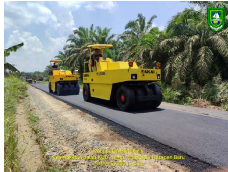
Gambar 3.1.21. Pemasadatan Menggunakan Pneumatic Tired Roller (Sumber: Dokumentasi Lapangan Kerja Praktek 2023)
