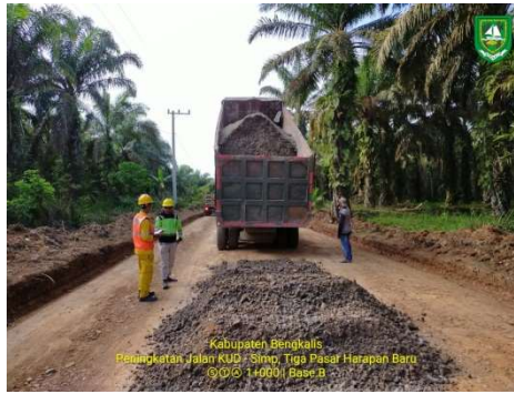
Gambar 3.2.1. pengangkutan menggunakan dump truck (Sumber: Dokumentasi Lapangan Kerja Praktek 2023)
