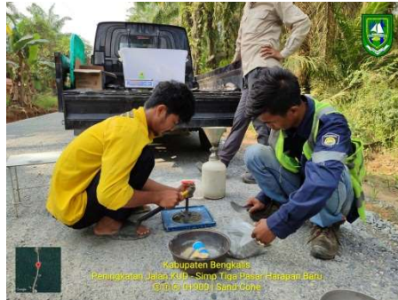
Gambar 3.2.10. Pekerjaan Sand Cone (Sumber: Dokumentasi Lapangan Kerja Praktek 2023)
