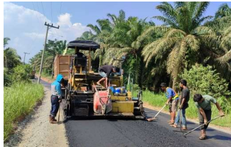
Gambar 3.2.21. Penghamparan Laston Lapis Aus (AC-WC) (Sumber: Dokumentasi Lapangan Kerja Praktek 2023)
