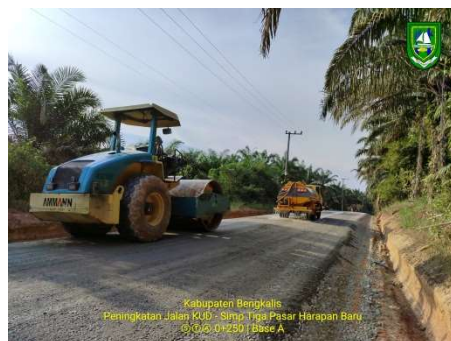
Gambar 4.3.3. pemadatan menggunakan vibro roller (Sumber: Dokumentasi Lapangan Kerja Praktek 2023)
