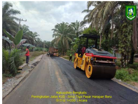
Gambar 3.1.20. Pemadatan Menggunakan Tandem Roller (Sumber: Dokumentasi Lapangan Kerja Praktek 2023)
