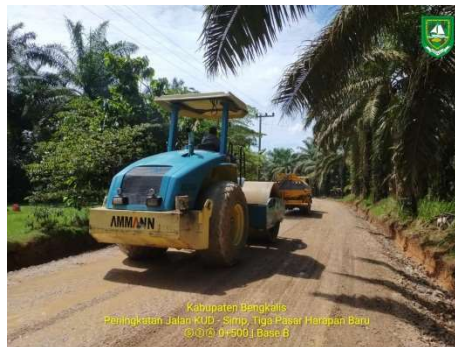
Gambar 3.2.3. pepadatan menggunakan vibro roller (Sumber: Dokumentasi Lapangan Kerja Praktek 2023)
