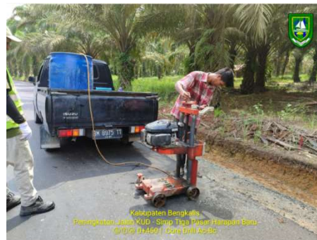
Gambar 3.1.22. Core Drill Test Laston Lapis Aus (AC-BC) (Sumber: Dokumentasi Lapangan Kerja Praktek 2023)
