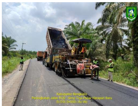
Gambar 3.2.19. Proses Masuk Laston Lapis Aus (AC-WC) ke dalam Asphalt Finisher (Sumber: Dokumentasi Lapangan Kerja Praktek 2023)
