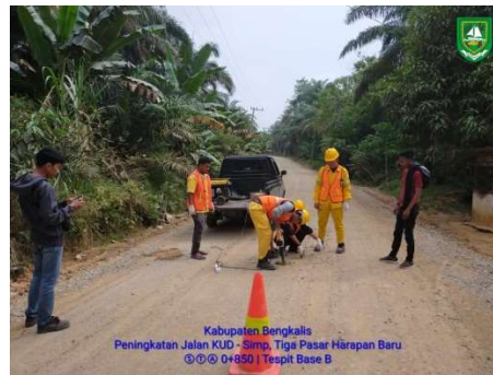
Gambar 3.2.4. Test Pit (Sumber: Dokumentasi Lapangan Kerja Praktek 2023)
