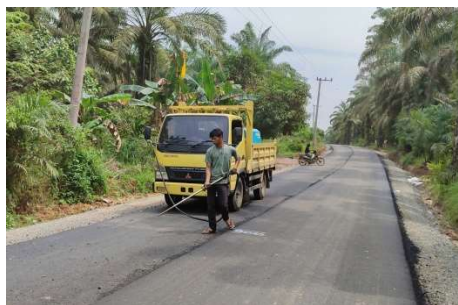
Gambar 3.2.16. Pembersihan Permukaan Base (Compressor) (Sumber: Dokumentasi Lapangan Kerja Praktek 2023)
