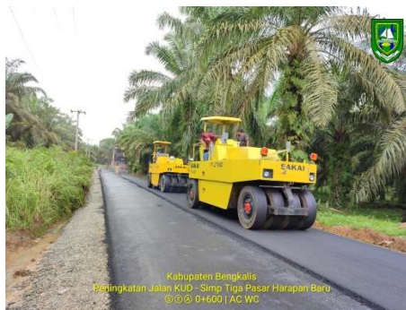
Gambar 3.1.23. Pematatan Menggunakan Pneumatic Tired Roller (Sumber: Dokumentasi Lapangan Kerja Praktek 2023)
