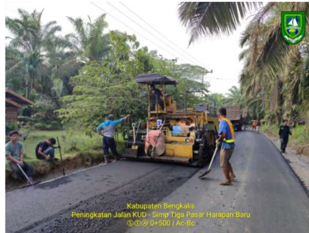
Gambar 3.2.19. Penghamparan Laston Lapis Aus (AC-BC) (Sumber: Dokumentasi Lapangan Kerja Praktek 2023)
