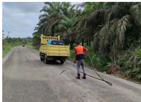
Gambar 3.2.14. Pembersihan Permukaan Base (Compressor) (Sumber: Dokumentasi Lapangan Kerja Praktek 2023)
