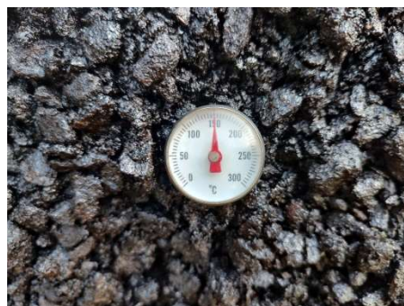
Gambar 3.2.20. Pengecekan Suhu Hampar Lapis Aus (AC-WC) (Sumber: Dokumentasi Lapangan Kerja Praktek 2023)
