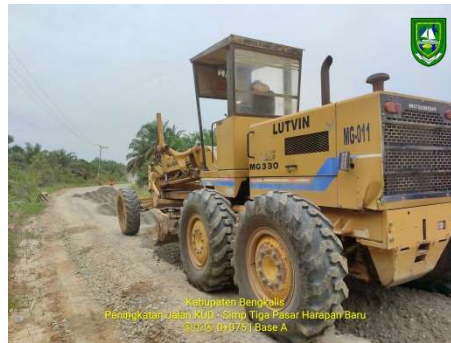
Gambar 3.2.7. Penghamparan Base B (Sumber: Dokumentasi Lapangan Kerja Praktek 2023)
