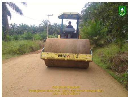
Gambar 3.2.13. pemadatan menggunakan vibro roller (Sumber: Dokumentasi Lapangan Kerja Praktek 2023)
