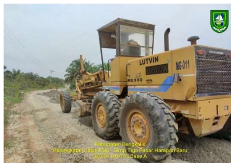
Gambar 4.3.2. Penghamparan Base B (Sumber: Dokumentasi Lapangan Kerja Praktek 2023)
