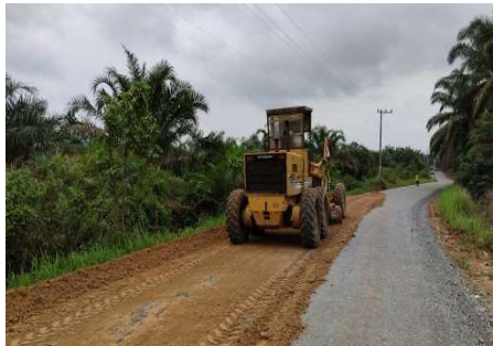
Gambar 3.2.12. Penghamparan Base B (Sumber: Dokumentasi Lapangan Kerja Praktek 2023)
