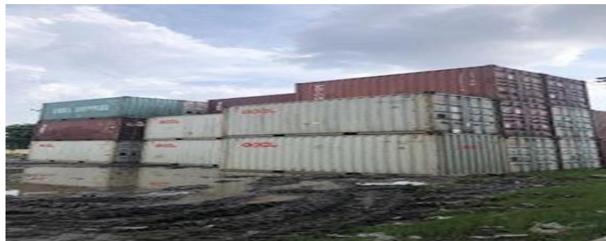
Gambar 4.10 Kondisi Lapangan Penumpukan Kurang Rata
