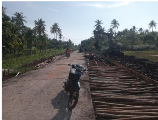
Gambar 3. 13 Pemasangan Kayu Gambangan (Sumber: Dokumentasi KP Konsultan Pengawas , 2023)
