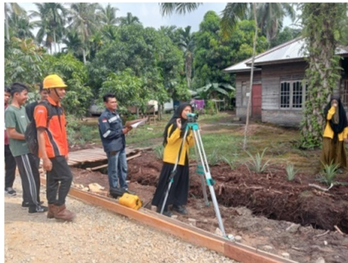
Gambar 3. 19 Pengukuran waterpass (Sumber: Dokumentasi KP Penulis, 2023)
