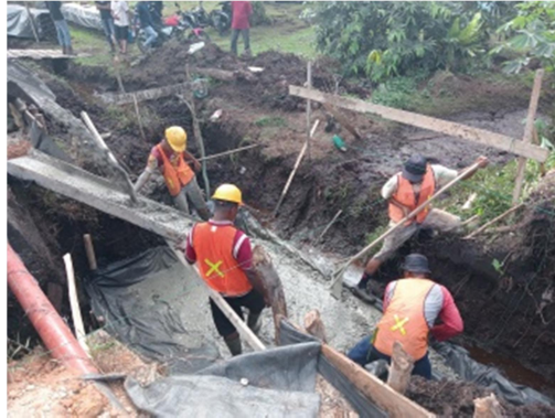
Gambar 4. 5 Pengecoran Lantai Kerja (Sumber: Dokumentasi KP Penulis, 2023)
