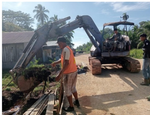
Gambar 3. 12 Penggalian tanah (Sumber: Dokumentasi KP Penulis, 2023)
