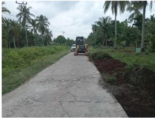
Gambar 3. 11 Pembersihan Lahan (Sumber: Dokumentasi KP Konsultan Pengawas, 2023)
