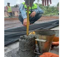
Proses pengukuran tinggi campuran beton dengan tinggi kerucut pada pengujian uji slump
