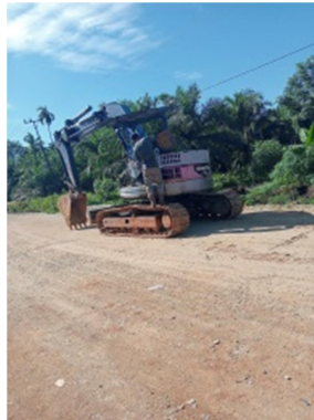
Gambar 3. 2 Excavator (Sumber : Dokumentasi KP Penulis,2023)
