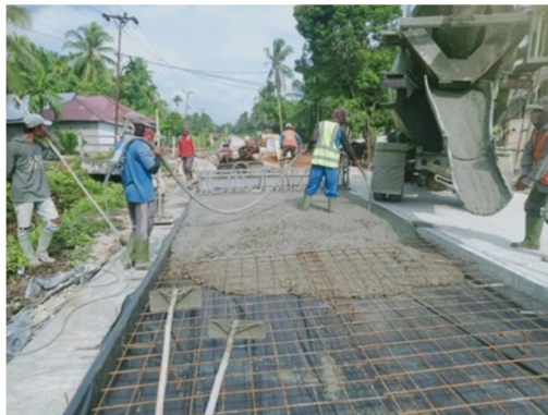
Gambar 3. 9 Concrete Vibrator (Sumber: Dokumentasi KP Penulis , 2023)
