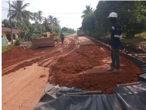
Gambar 3. 15 Timbunan Tanah Pilihan (Sumber: Dokumentasi KP Konsultan Pengawas, 2023)
