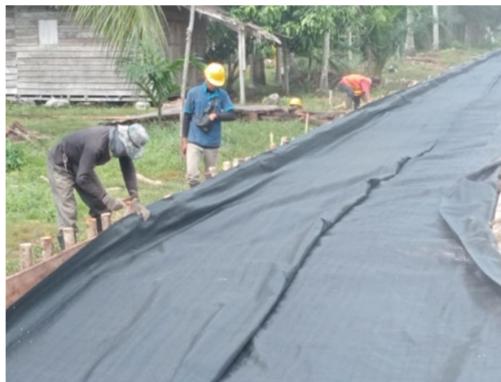
Gambar 3. 14 Pemasangan Geotex Woven (Sumber: Dokumentasi KP Konsultan Pengawas , 2023)
