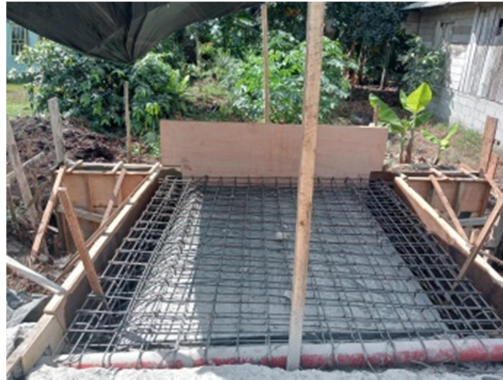
Gambar 4. 8 Kondisi sebelum pengecoran (Sumber: Dokumentasi KP Penulis, 2023)
