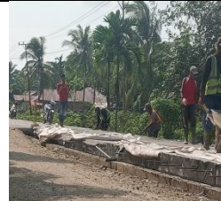
Proses pengecoran bahu jalan
