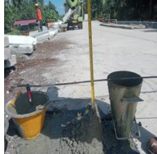
Proses pengukuran tinggi campuran beton dengan tongkat kerucut pada pengujian uji slump
