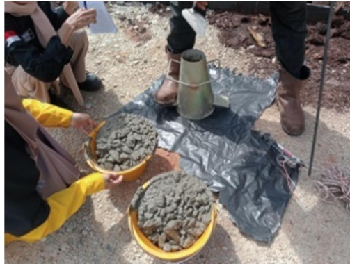
Gambar 4. 6 Proses Uji Slump (Sumber: Dokumentasi KP Penulis, 2023)
