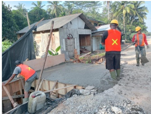
Gambar 4. 9 Proses Pengecoran Box (Sumber: Dokumentasi KP Penulis, 2023)
