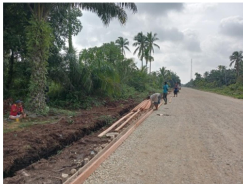
Gambar 3. 20 Pemasangan LC (Sumber: Dokumentasi KP Penulis, 2023)
