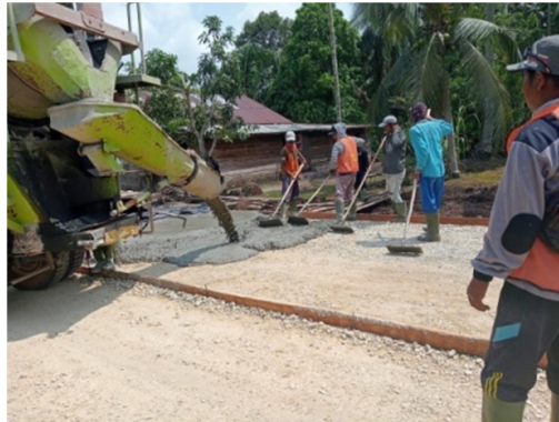
Gambar 3. 21 Pengecoran LC (Sumber: Dokumentasi KP Penulis, 2023)
