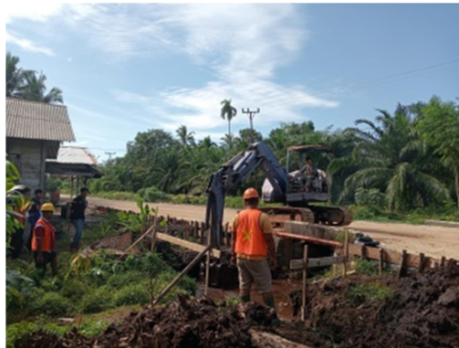
Gambar 4. 2 Penggalian Box (Sumber: Dokumentasi KP Penulis, 2023)
