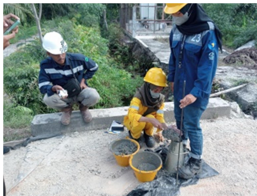
Gambar 4. 11 Proses Pengujian Slump (Sumber: Dokumentasi KP Penulis, 2023)
