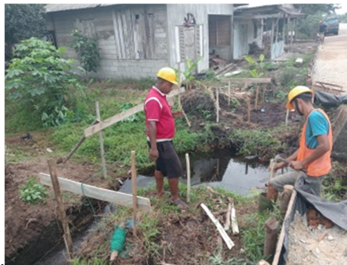
Gambar 4. 1 Pemasangan Bowplank (Sumber: Dokumentasi KP Penulis, 2023)
