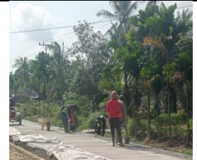
Proses meratakan menggunakan ruskam kayu
