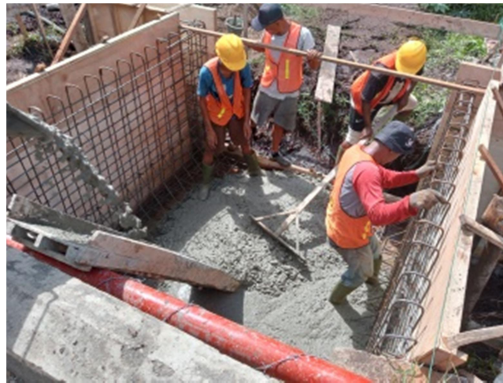
Gambar 4. 7 Pengecoran slab lantai (Sumber: Dokumentasi KP Penulis, 2023)
