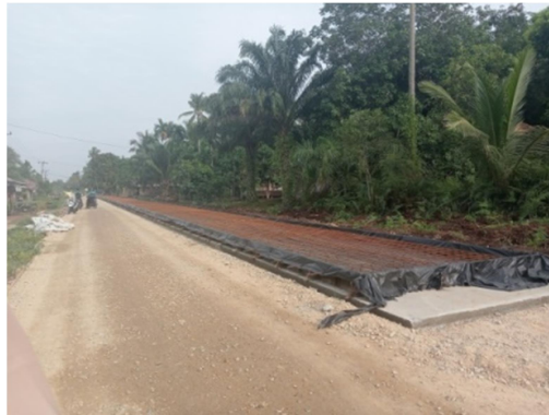
Gambar 3. 22 Pemasangan mal rigid dan penulangan (Sumber: Dokumentasi KP Penulis, 2023)
