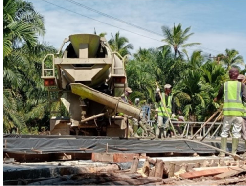
Gambar 3. 23 Pengecoran rigid (Sumber: Dokumentasi KP Penulis, 2023)
