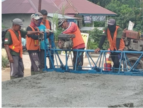
Gambar 3. 10 Concrete Truss Screed (Sumber: Dokumentasi KP Penulis, 2023)
