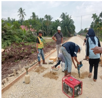
Gambar 3. 17 Pengujian Test Pit (Sumber: Dokumentasi KP, 2023)
