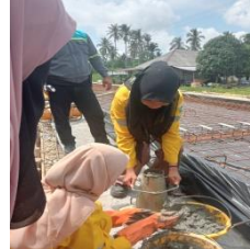
Proses memasukkan campuran beton kedalam kerucut abrams menggunakan sendok semen
