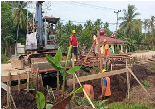
Gambar 4. 3 Pemasangan Kayu Cerucuk (Sumber: Dokumentasi KP Penulis, 2023)
