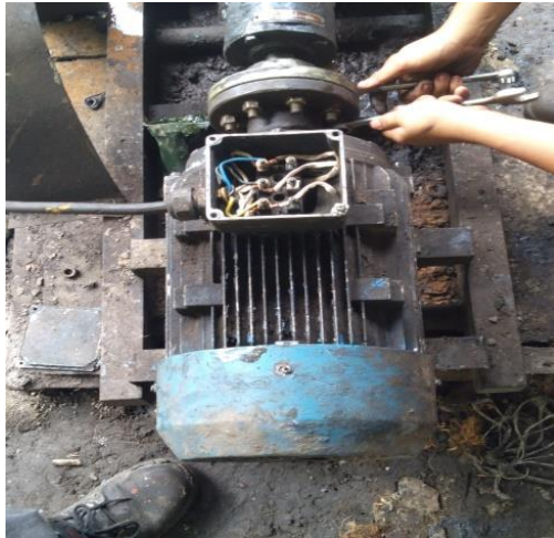
Gambar 2. 56 pemasangan elmot pompa klarifikasi
