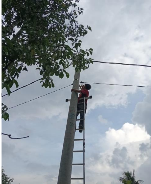
Gambar 2. 60 pemasangan instalasi listrik
