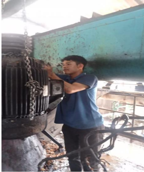
Gambar 2. 58 pemasangan elmot di gester
