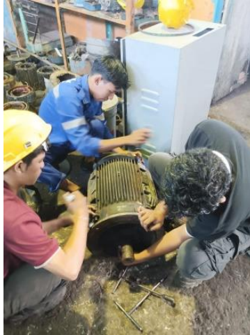
Gambar 2. 49 membongkar elmot
