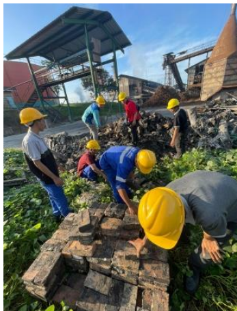
Gambar 2. 11 menyusun batu bata bekas dari boiler
