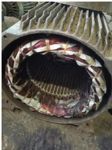
Gambar 2. 62 membongkar elmot yang terbakar
