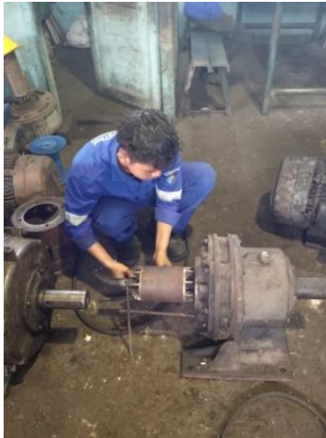
Gambar 2. 61 membongkar elmot gearbox
