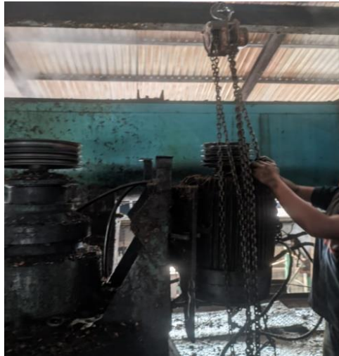
Gambar 2. 30 pemasangan elmot di gester
