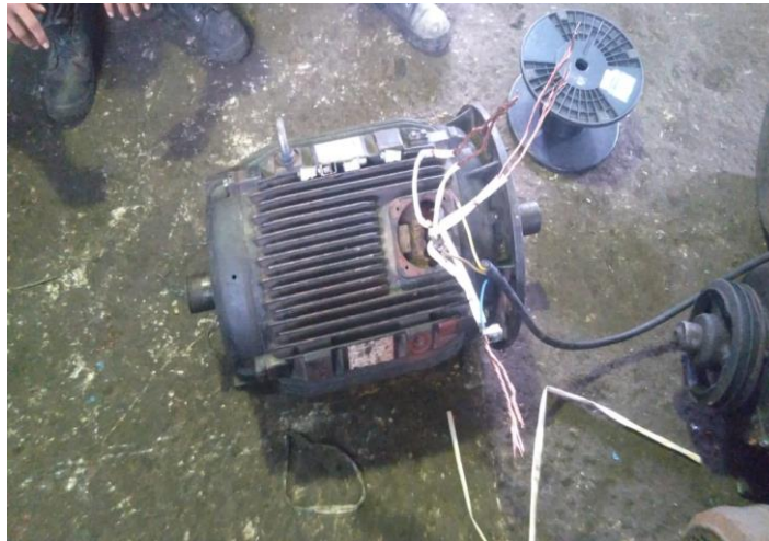
Gambar 2. 27 pemasangan elmot raw water pump
