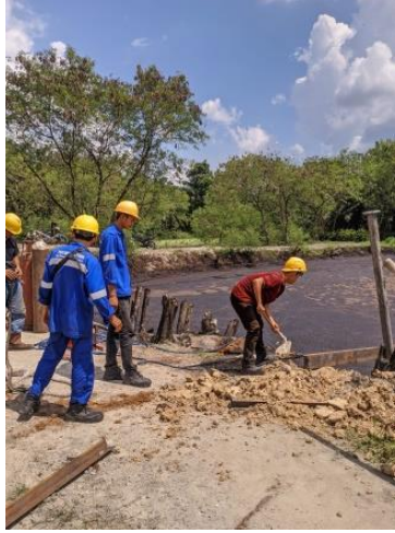
Gambar 2. 13 penggantian pompa limbah
