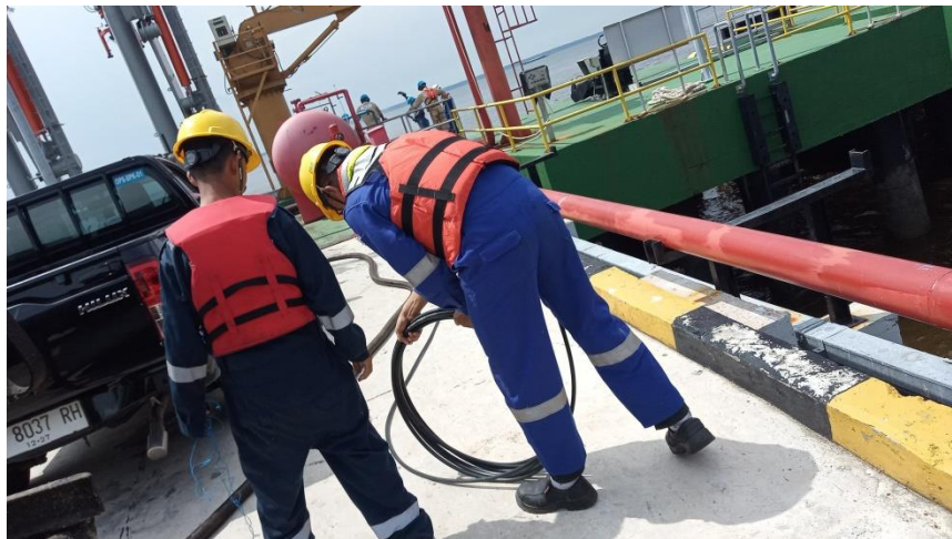
Gambar 3. 5 Penarikan Kabel FO (Fiber Optic)
