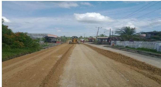
Gambar 3.3 Pekerjaan Agregat Kelas A
