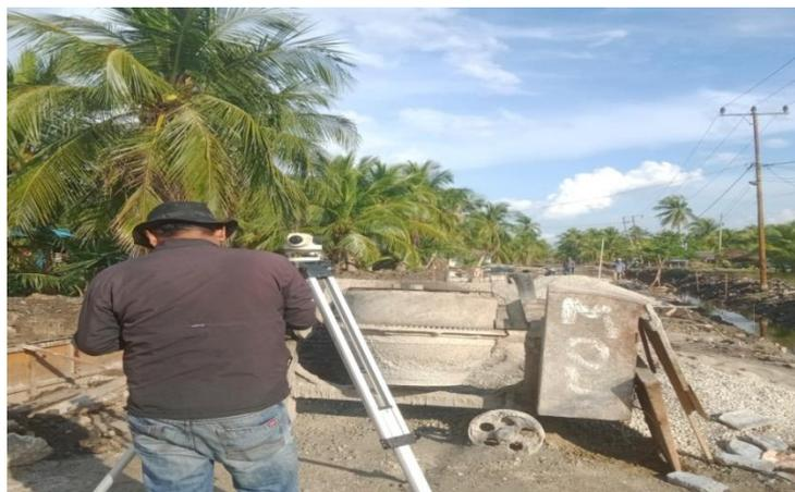
Gambar 2.2 Pengukuran Jalan Menggunakan *Waterpass*
