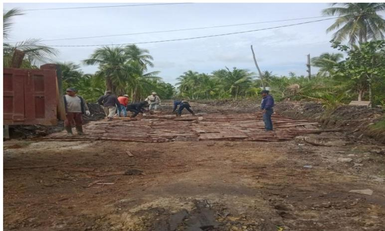
Gambar 2.3 Pekerjaan Penyusunan Gambangan (*Uyung Sagu*)
