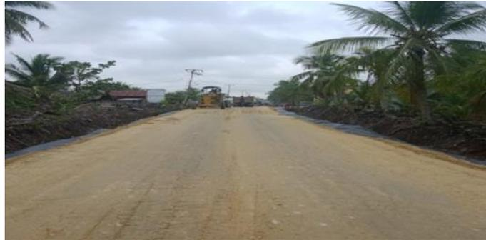
Gambar 3.2 Pekerjaan Agregat Kelas B
