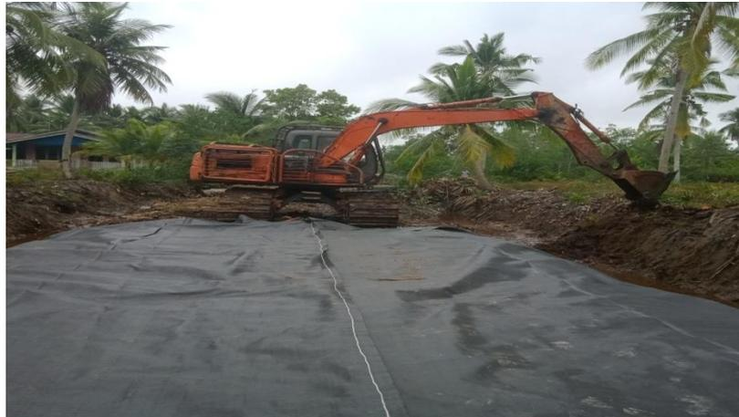
Gambar 2.4 Pemasangan Geotextile Woven
