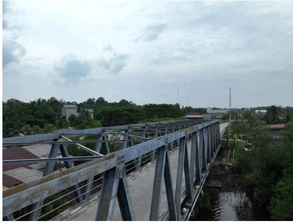
Gambar 1.2 Jembatan Selat Morong Sumber: Dokumentasi Lapangan 2024
