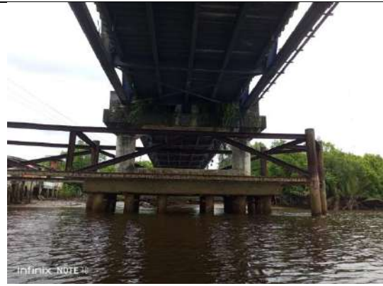
TAMPAK BAWAH JEMBATAN
