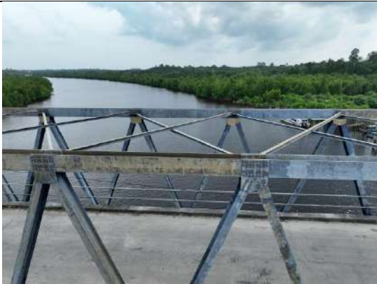
ARAH HULU JEMBATAN
