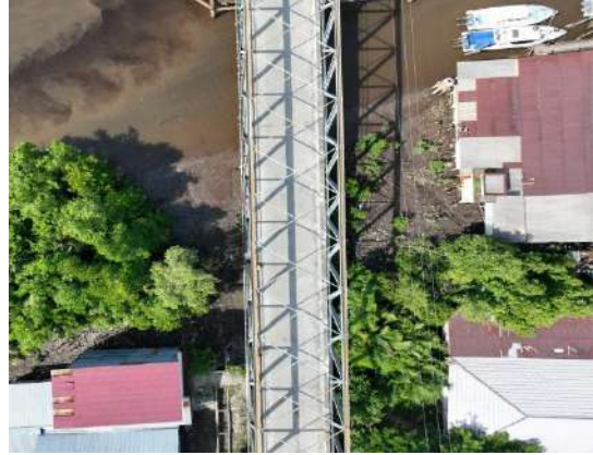
TAMPAK ATAS JEMBATAN
