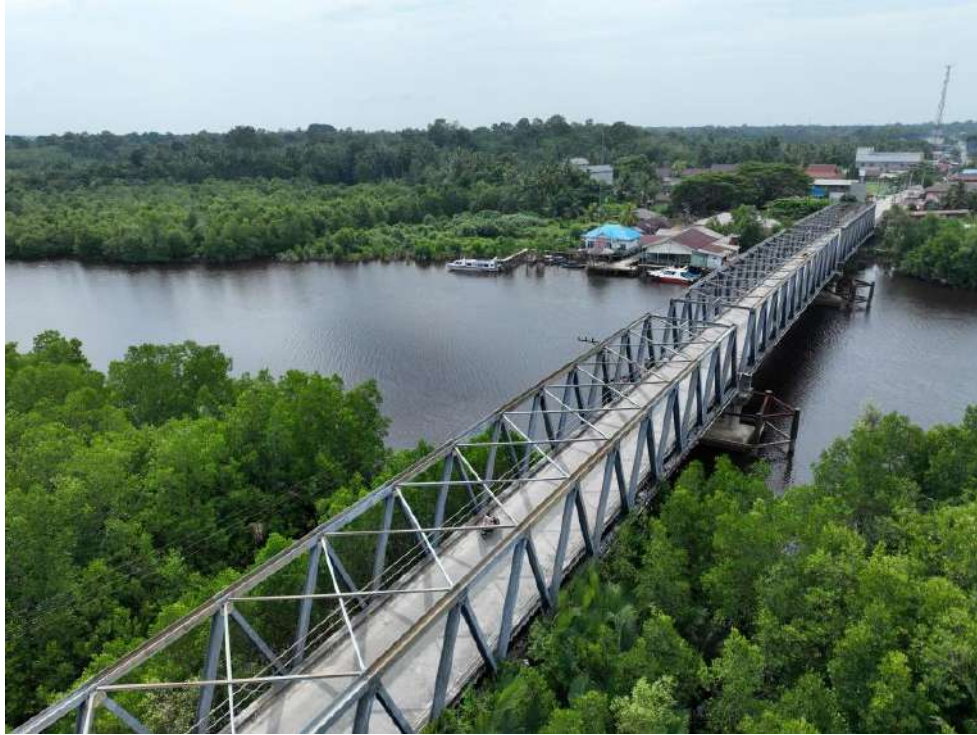
Gambar 3.2 Jembatan Selat Morong Sumber: Dokumentasi Lapangan 2024
