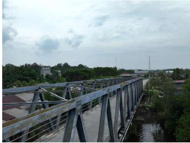
Gambar 1.2 Jembatan Selat Morong Sumber: Dokumentasi Lapangan 2024
