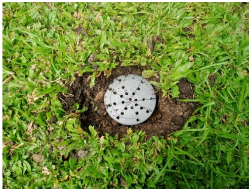
Gambar 3.20 Biopori Yang Sudah Di Tanam
