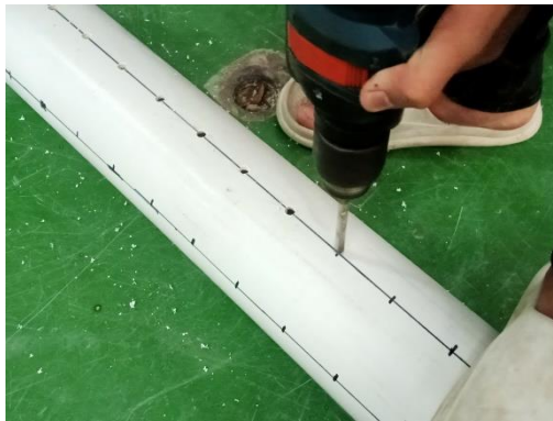
Gambar 3.15 Proses pengeboran pipa
