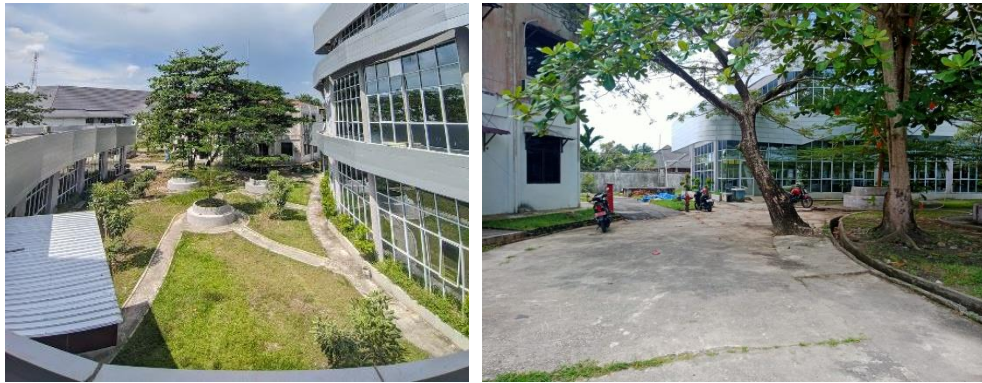
Gambar 1.2 Halaman Gedung Teknik Sipil POLBENG Yang Sering Terjadi Genangan Air Sumber : Dokumentasi Pribadi, 2024
