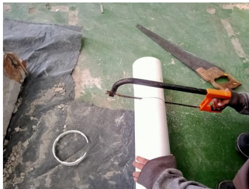
Gambar 3.13 Pemotongan pipa PVC
