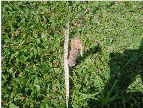
Gambar 3.17 Pemasangan Patok
