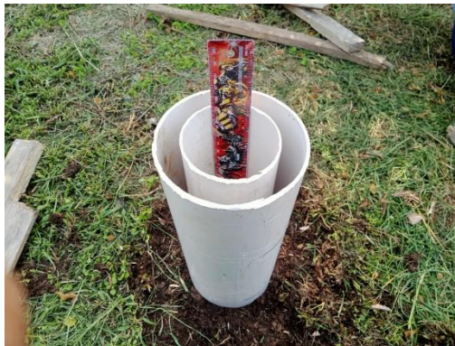
Gambar 3.10 Pemasangan penggaris ke pipa
