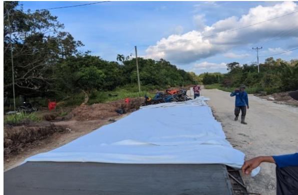
Gambar 3.1.20 Menutup Permukaan Beton dengan Geotextile (Sumber : Dokumentasi Lapangan)
