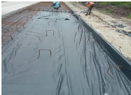
Gambar 4.2 Pekerjaan Pemasangan Dudukan Wiremesh (Sumber : Dokumentasi Lapangan)
