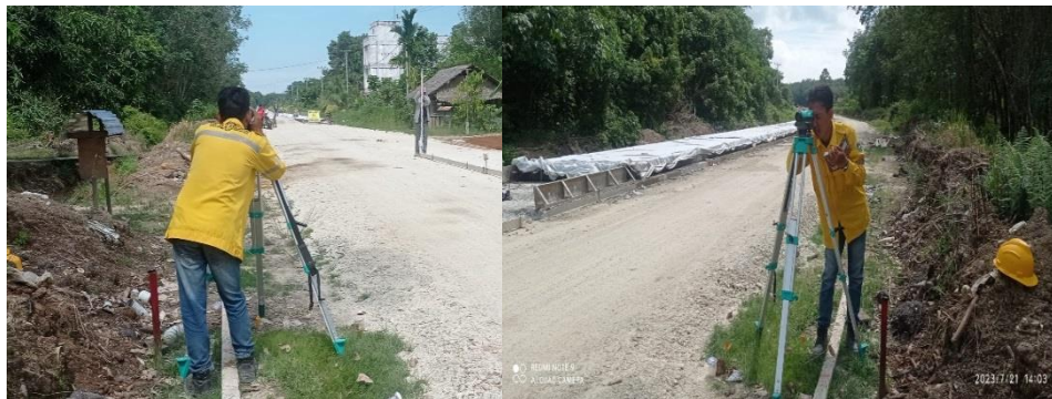
Gambar 3.1 pembacaan levelling base menggunakan waterpass Sumber: Dokumentasi Lapangan, 2023
