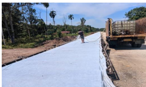
Gambar 3.1.21 Pekerjaan Penyiraman Beton (Sumber : Dokumentasi Lapangan)
