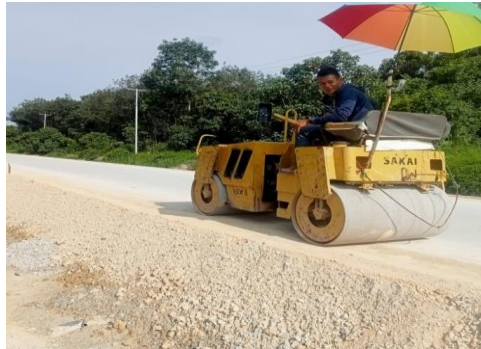
Gambar 3.1.27 Pekerjaan pemadatan (Sumber : Dokumentasi Lapangan)
