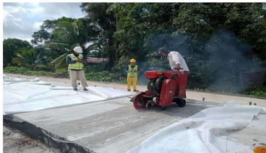
Gambar 3.1.22 Pekerjaan Cutting (Sumber : Dokumentasi Lapangan)
