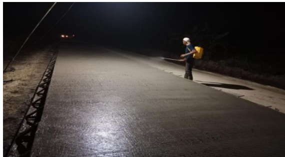
Gambar 3.19 curing compound (Sumber : Dokumentasi Lapangan)
