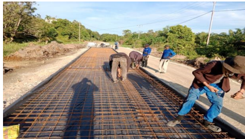
Gambar 4.3 Pekerjaan Pemasangan wiremesh (Sumber : Dokumentasi Lapangan)
