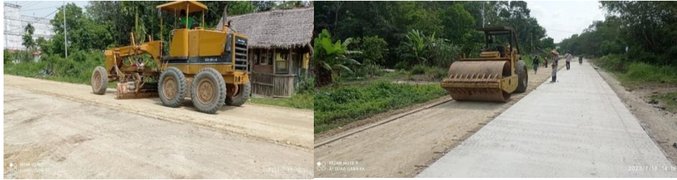
Gambar 3.2 Pemotongan dan Pemasangan menggunakan Motor Grader dan Vibro Roller Sumber: Dokumentasi Lapangan, 2023
