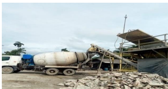
Gambar 3.4 Pembuatan Beton Ready Mix Sumber : (Dokumentasi lapangan)
