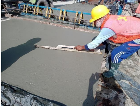
Gambar 3.17 Diratakan Menggunakan Ruskam (Sumber : Dokumentasi Lapangan)
