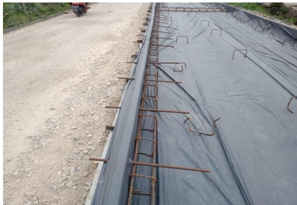
Gambar 3.12 Pekerjaan Pemasangan Tie Bar (Sumber : Dokumentasi Lapangan)
