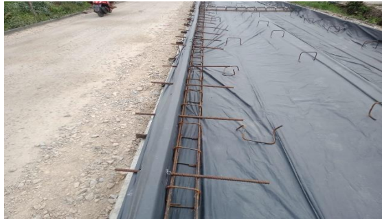
Gambar 4.4 Pekerjaan Pemasangan Tie Bar (Sumber : Dokumentasi Lapangan)
