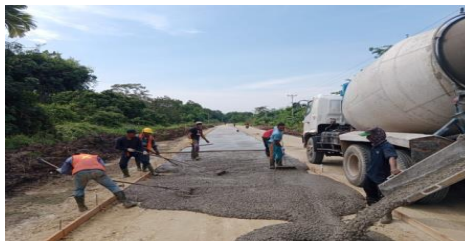
Gambar 3.7 Pengecoran Lc (Sumber : Dokumentasi Lapangan)
