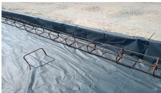
Gambar 3.10 Pekerjaan Pemasangan Tulangan Bangku (Sumber : Dokumentasi Lapangan)
