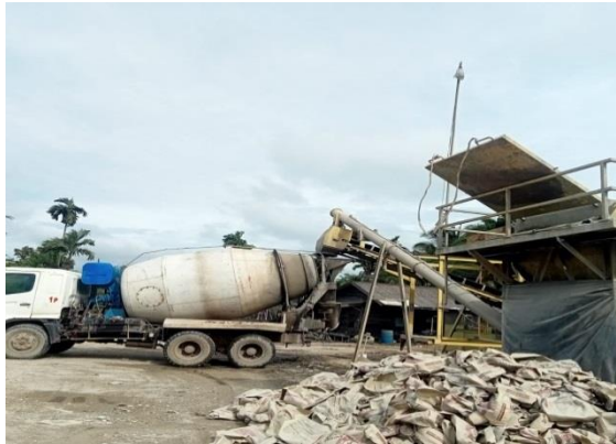
Gambar 3. 13 Pembuatan beton Ready mix Sumber : Dokumentasi lapangan,
