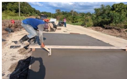
Gambar 3.18 Pekerjaan Grooving (Sumber : Dokumentasi Lapangan)
