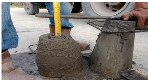
Gambar 3. 14 Slump Test f'c 30 mpa Sumber : Dokumentasi lapangan,
