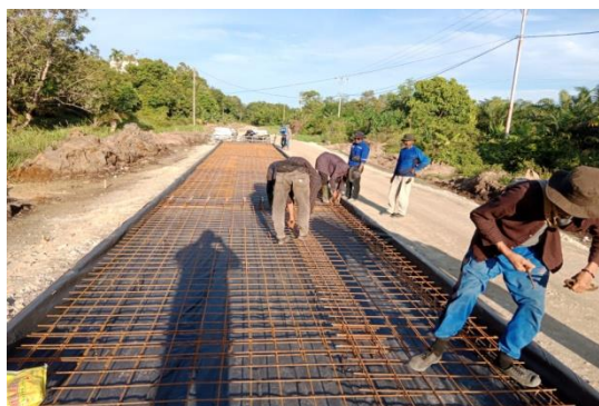
Gambar 3.11 Pekerjaan Pemasangan wiremesh dan dudukan wiremesh (Sumber : Dokumentasi Lapangan)
