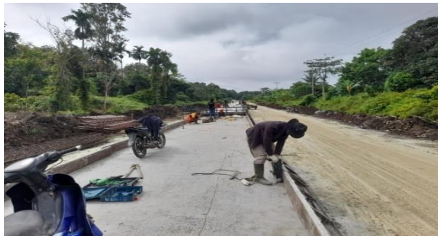
Gambar 3.8 Pemasangan Bekisting Rigid (Sumber : Dokumentasi Lapangan)
