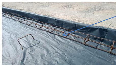
Gambar 4.1 Pekerjaan Pemasangan Tulangan dudukan tie bar (Sumber : Dokumentasi Lapangan)
