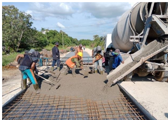
Gambar 3.16 Pengecoran Rigid (Sumber : Dokumentasi Lapangan)
