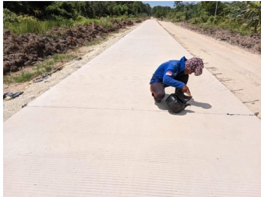
Gambar 3..23 Pekerjaan Joint Sealant (Sumber : Dokumentasi Lapangan)
