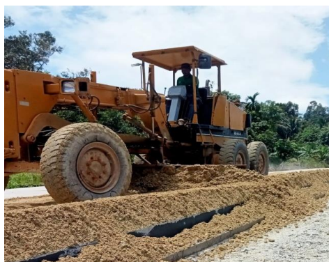
Gambar 3.1.26 Pekerjaan penurunan base (Sumber : Dokumentasi Lapangan)
