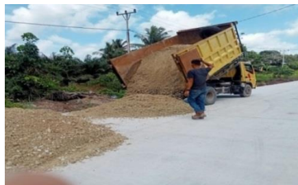
Gambar 3.1.25 Pekerjaan penghamparan base (Sumber : Dokumentasi Lapangan )
