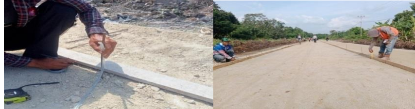
Gambar 3.3 Pemasangan Bekisting Lc (Sumber : Dokumentasi Lapangan)
