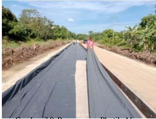
Gambar 3.9 Pemasangan Plastik Alas (Sumber : Dokumentasi Lapangan)
