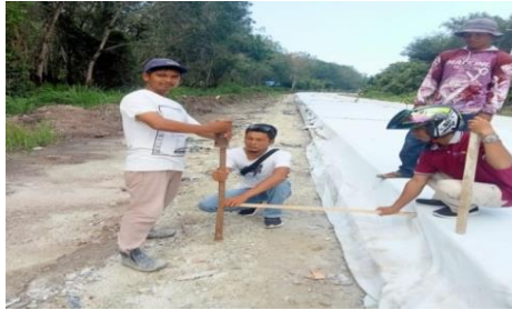
Gambar 3.1.24 Pekerjaan pengukuran bahu (Sumber : Dokumentasi Lapangan )
