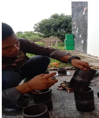
Gambar 4.78 Penyemprotan anti korosi clear
