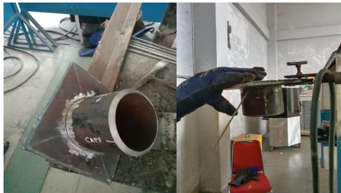
Gambar 4.37 Pemasangan tanggem pada meja kerja
