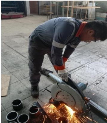
Gambar 4.27 pemotongan pipa menggunakan gerinda duduk Sumber: Penulis
