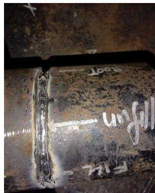
Gambar 4.61 Hasil repair inspeksi visual 5G Butt joint Sumber: Penulis
