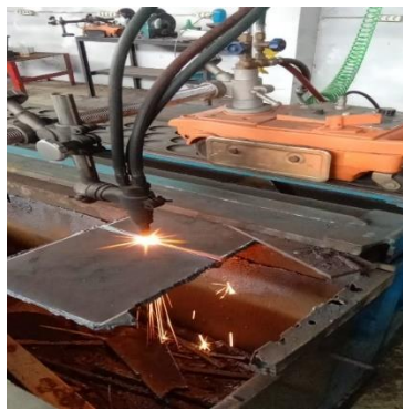
Gambar 4.31 Pemotongan plat menggunakan cutting torch semi automatic Sumber: Penulis
