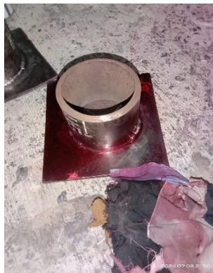
Gambar 4.68 Membersihkan cairan penetrant pada permukaan pengelasan.
