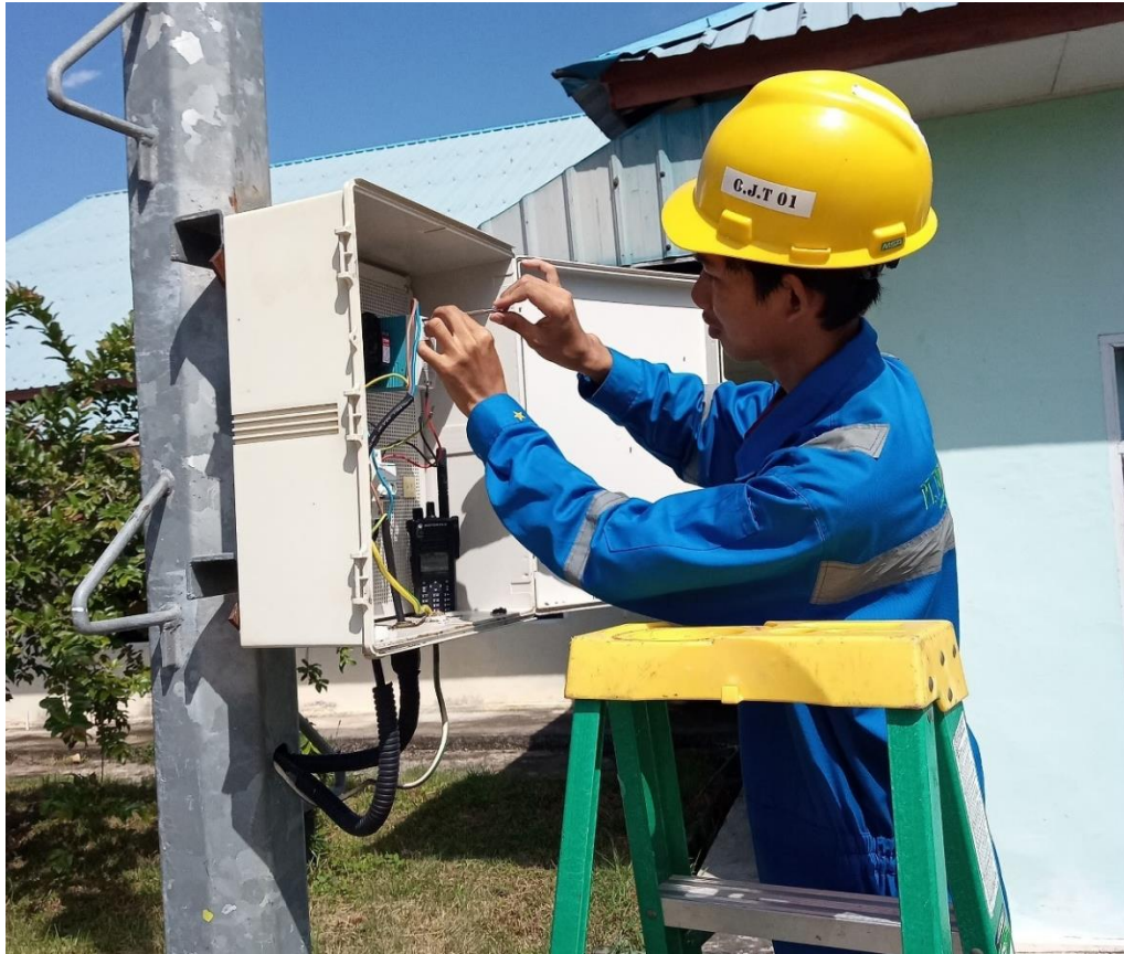
Gambar 3. 4 Pemasangan Adaptor CCTV
