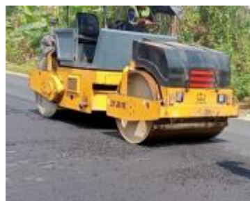
gambar 4. 8 Proses pematatan awal dengan tandem roller
