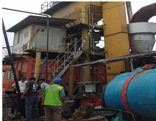
gambar 4. 2 Pemasukkan campuran aspal kedalam dump truck dari AMP
