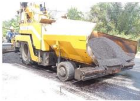
gambar 4. 6 Pekerjaan penghampanan dengan asphalt finisher
