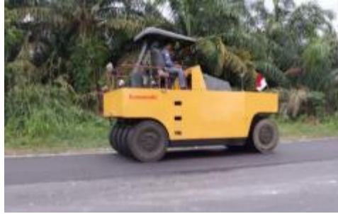
Gambar Proses pemadatan akhir dengan pneumatic tyred roller
