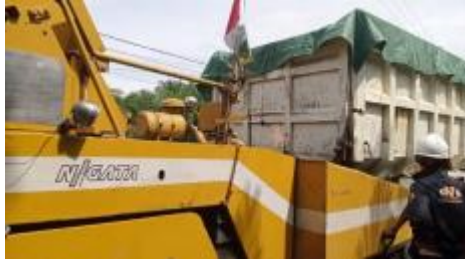
gambar 4. 5 Proses penghampanan dengan asphalt finisher
