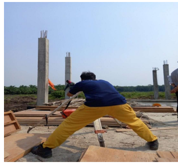
Gambar 3.18 Pembidikan elevasi lantai kerja dengan waterpass Sumber : Dokumentasi lapangan
