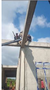
Gambar 3.35 Pekerjaan erection rangka baja Sumber : Dokumentasi lapangan
