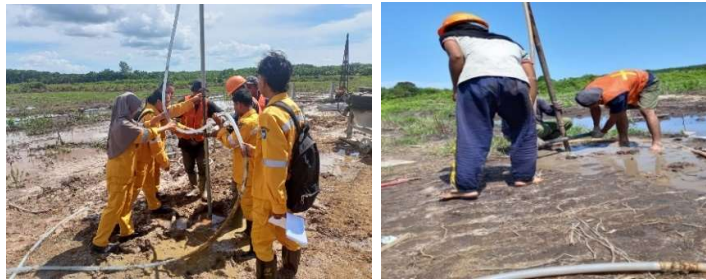
Gambar 3.10 Pengeboran Sumber : Dokumentasi Proyek
