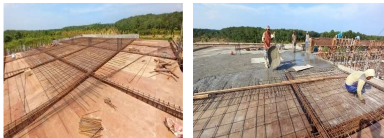
Gambar 3.26 Pekerjaan perakitan tulangan & pengecoran plat lantai
