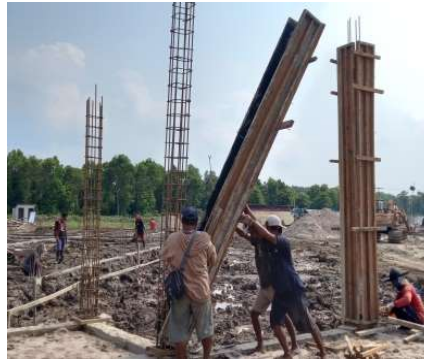
Gambar 3.23 Proses pemasangan bekisting kolom Sumber : Dokumentasi lapangan
