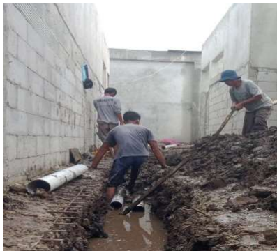
Gambar 3.40 Pekerjaan pemasangan pipa saluran air
