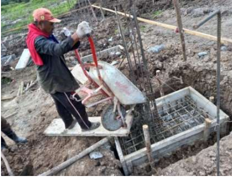
Gambar 3.20 Pengecoran pondasi pile cap Sumber : Dokumentasi lapangan
