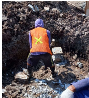
Gambar 3.15 Pemecahan kepala tiang pancang Sumber : Dokumentasi lapangan
