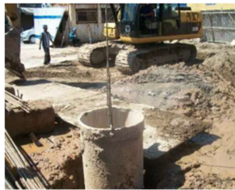
Gambar 3.9 Casing temporary Sumber : Dokumentasi Proyek
