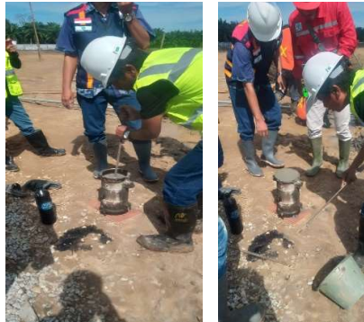
Gambar 3.30 Proses pembuatan sampel beton silinder Sumber : Dokumentasi lapangan
