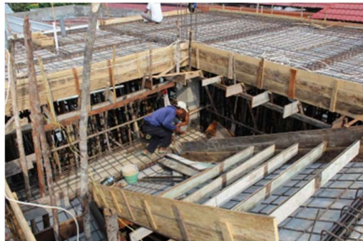
Gambar 3.29 Pekerjaan perakitan tulangan & bekisting tangga Sumber : Dokumentasi lapangan
