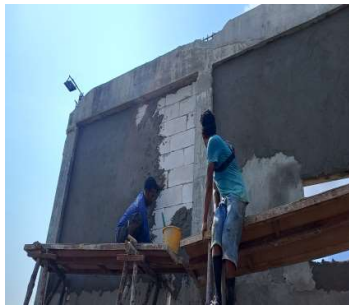
Gambar 3.37 Pekerjaan plasteran dinding Sumber : Dokumentasi lapangan
