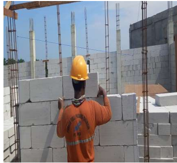
Gambar 3.36 Pekerjaan pemasangan dinding bata Sumber : Dokumentasi lapangan
