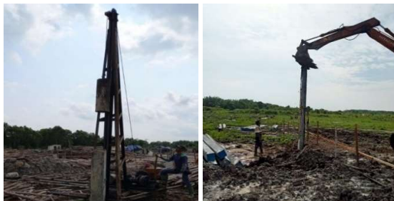
Gambar 3.13 Pekerjaan pemancangan tiang pancang Sumber : Dokumentasi lapangan
