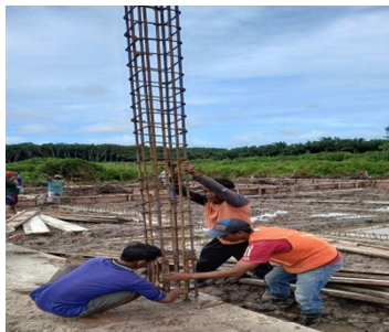
Gambar 3.22 Proses pemasangan penulangan kolom Sumber : Dokumentasi lapangan
