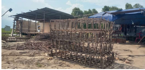
Gambar 3.19 Fabrikasi Pembesian/penulangan di lokasi proyek Sumber : Dokumentasi lapangan
