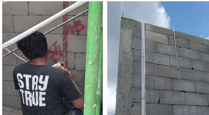
Gambar 3.42 Pekerjaan pembobokan & pemasangann pipa listrik Sumber : Dokumentasi lapangan
