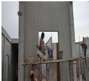
Gambar 3.38 Pekerjaan acian Sumber : Dokumentasi lapangan
