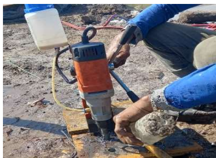
Gambar 3.34 Pekerjaan pembuatan sambungan baut pengikat Sumber : Dokumentasi lapangan
