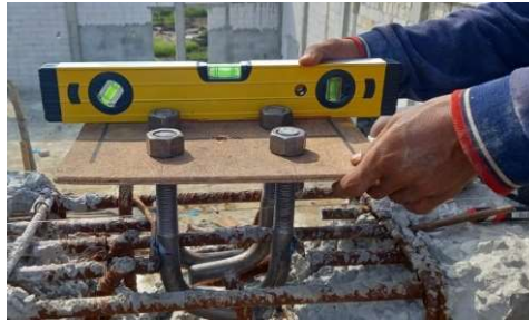
Gambar 3.32 Pekerjaan koreksi pemasangan anker Sumber : Dokumentasi lapangan
