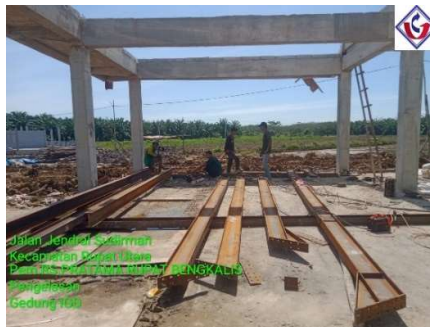
Gambar 3.33 Pekerjaan pengelasan sambungan baja Sumber : Dokumentasi lapangan
