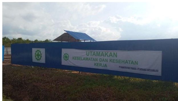
Gambar 3.8 Pemasangan pagar pengaman proyek Sumber : Dokumentasi Lapangan
