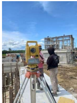
Gambar 3.31 Pembidikan perletakkan anker baja Sumber : Dokumentasi lapangan
