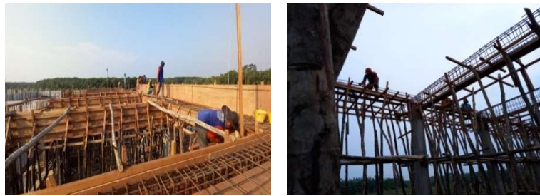
Gambar 3.25 Pekerjaan ring balok
