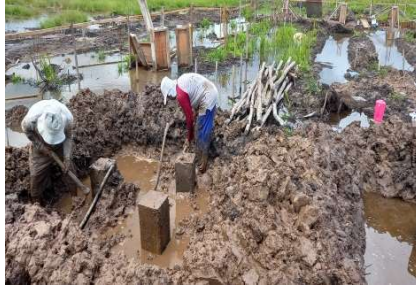
Gambar 3.14 Galian tapak pilecap Sumber : Dokumentasi lapangan
