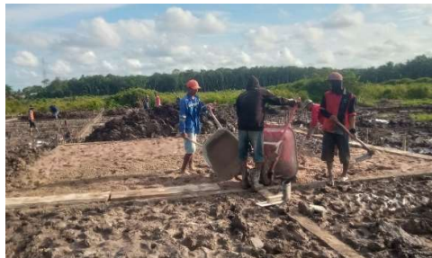
Gambar 3.16 Pekerjaan Urugan Pasir Sumber : Dokumentasi lapangan
