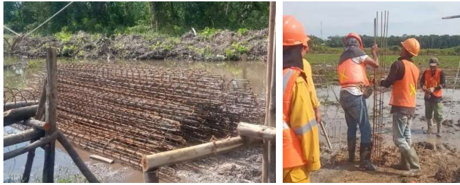
Gambar 3.12 Pemasangan Penulangan Strousse Pile Sumber : Dokumentasi Proyek
