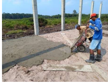
Gambar 3.17 Pekerjaan lantai kerja Sumber : Dokumentasi lapangan
