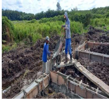
Gambar 3.21 Proses pekerjaan balok sloof Sumber : Dokumentasi lapangan
