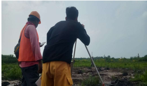
Gambar 3.6 Survey Pemasangan Bouwplank Sumber : Dokumentasi lapangan
