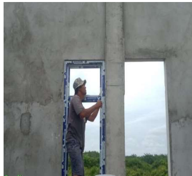
Gambar 3.39 Pemasangan kusen jendela
