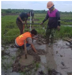
Gambar 3.11 Cleaning Sumber : Dokumentasi Proyek
