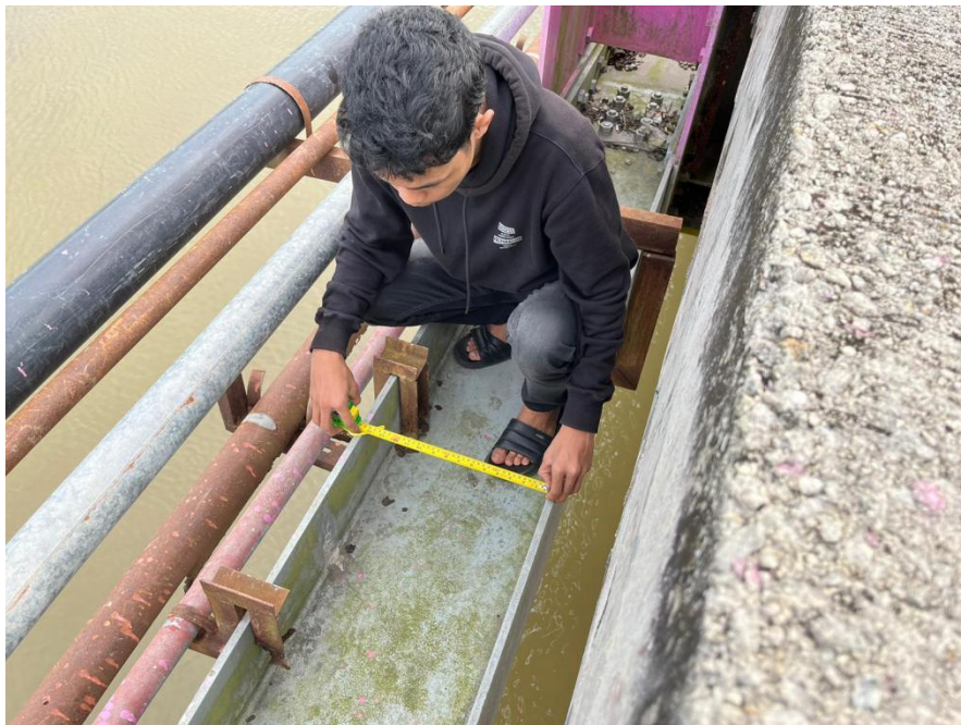
Lampiran A. 2 Pengukuran Dimensi Batang Tepi Bawah
