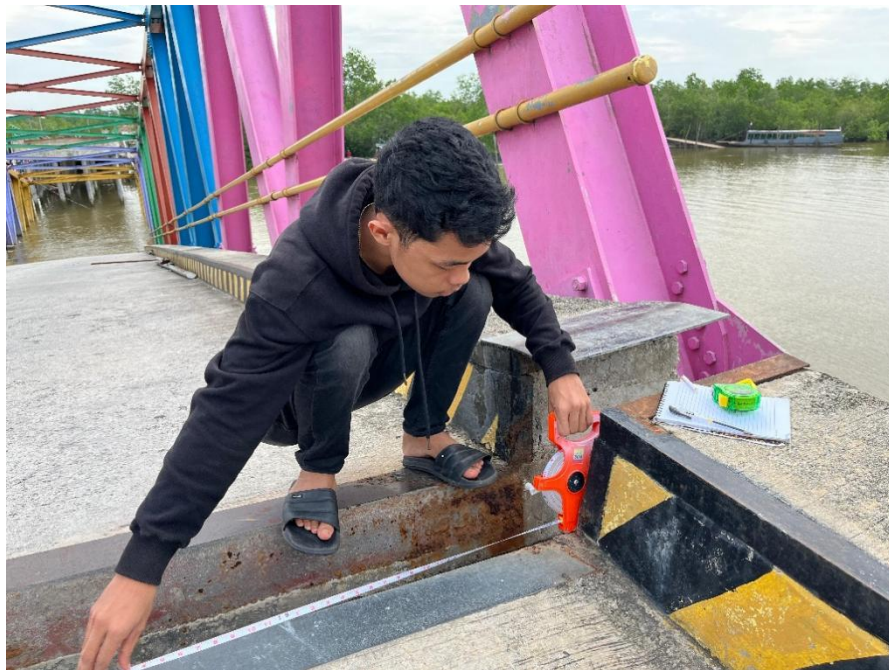
Lampiran A. 6 Pengukuran Lebar Jalan
