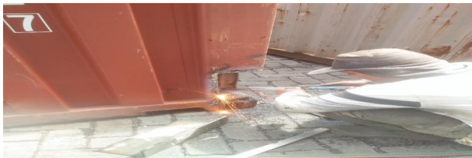
Gambar 4.5 Penggantian komponen container
