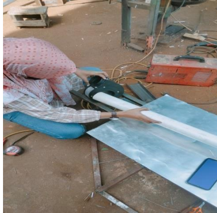
Gambar 4.11 Proses Fitting Atau Penyesuaian peletakan Blower
