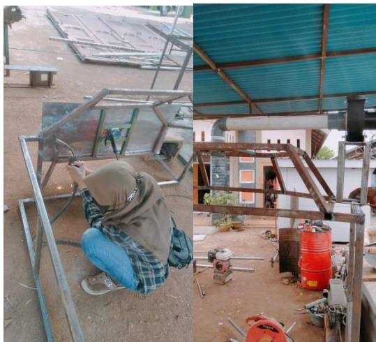
Gambar 4.12 Proses Joining Atau Penyambungan Konstruksi Kerangka Mesin
