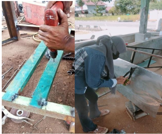
Gambar 4.13 Proses Pengeboran dan pemasangan atap
