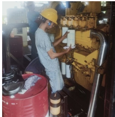
Gambar 2. 20 Kegiatan penggantian filter oli unit lima
