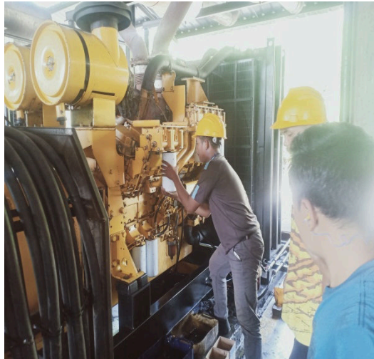
Gambar 2. 23 Kegiatan pengantian filter oli pada unit 5
