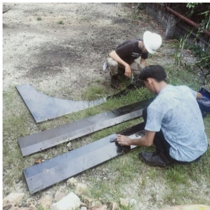
Gambar 2. 12 Kegiatan membersihkan cover radiator unit empat
