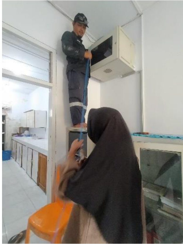
Gambar 3. 8 Pemasangan Jaringan Telepon
