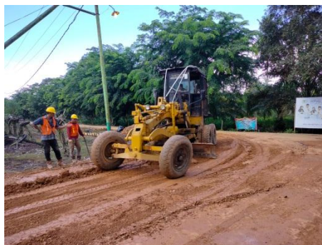
Gambar 3.20 Penghamparan Tanah Timbunan
