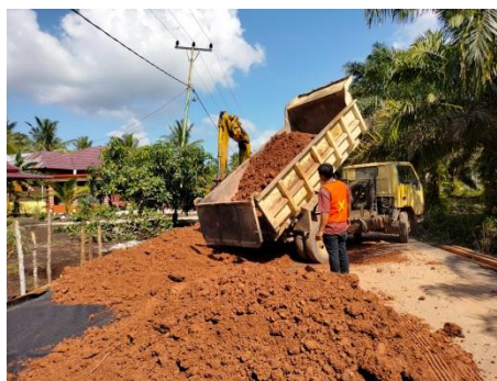
Gambar 3.13 Tanah Timbunan
