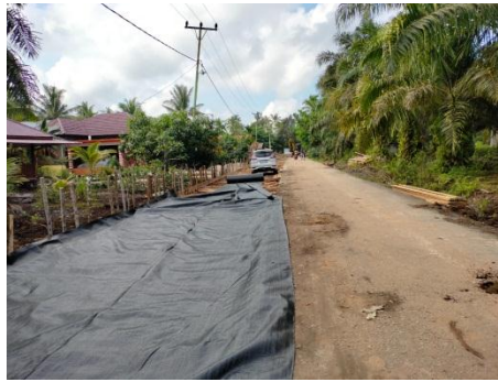
Gambar 3.19 Pemasangan Geotek
