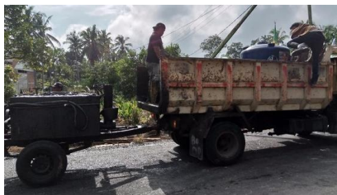
Gambar 3.29 Pekerjaan Prime Coat
