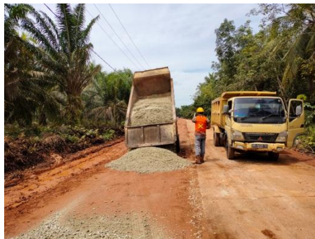
Gambar 3.12 Lapis Pondasi Agregat Kelas B
