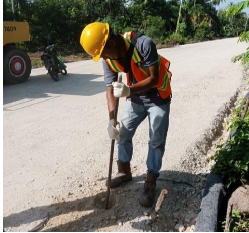
Gambar 3.27 Pekerjaan Core Drill Base A
