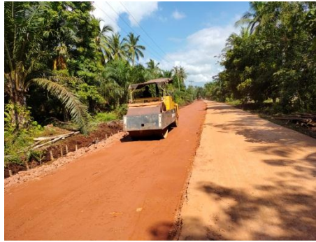
Gambar 3.21 Pemadatan Tanah Timbunan
