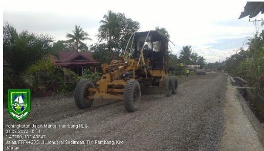
Gambar 3.26 Pekerjaan Agregat Kelas A
