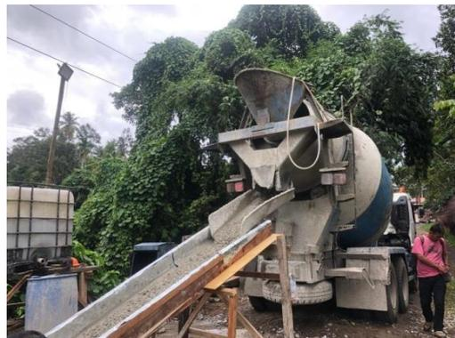
*Gambar 4 3 Talang pengecoran*
