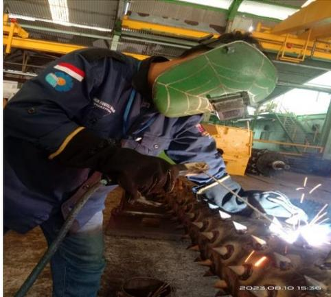
Gambar 3.8 pengelasan pada *Washing roll*
