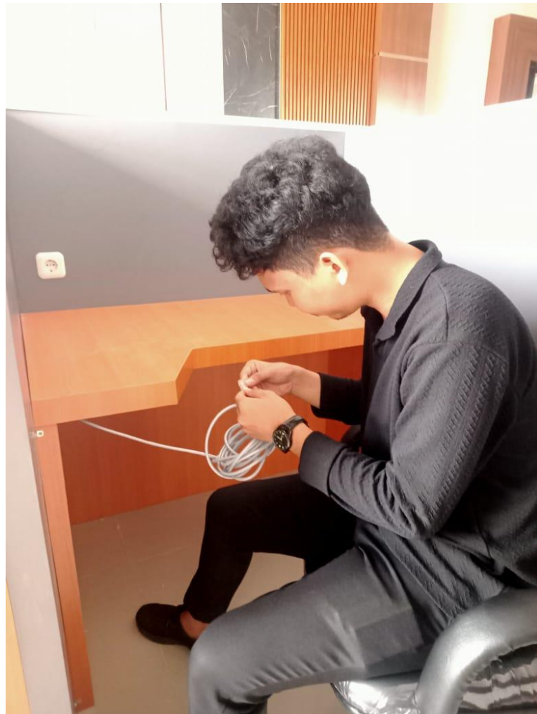
Gambar 3. 3 Pemasangan Kabel Lan RJ45 di Kantor Humas Polda Riau
