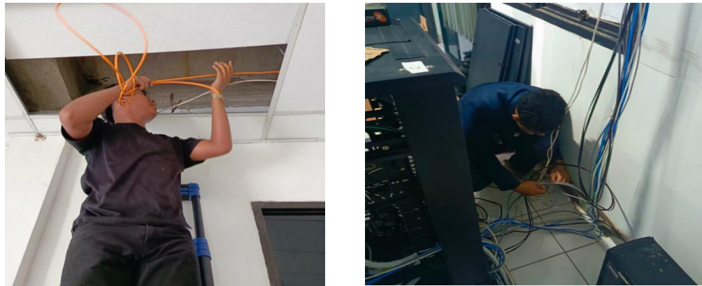
Gambar 3. 6 Proses penarikan kabel
