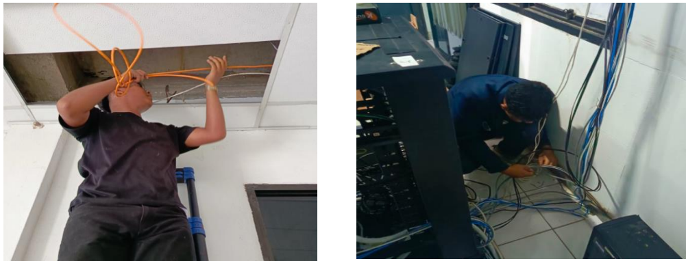
Gambar 3. 5 Proses penarikan kabel
