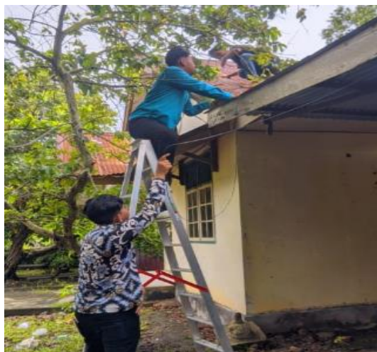
Gambar 3. 4 Proses Pemasangan (Sumber : Dokumen Pribadi )
